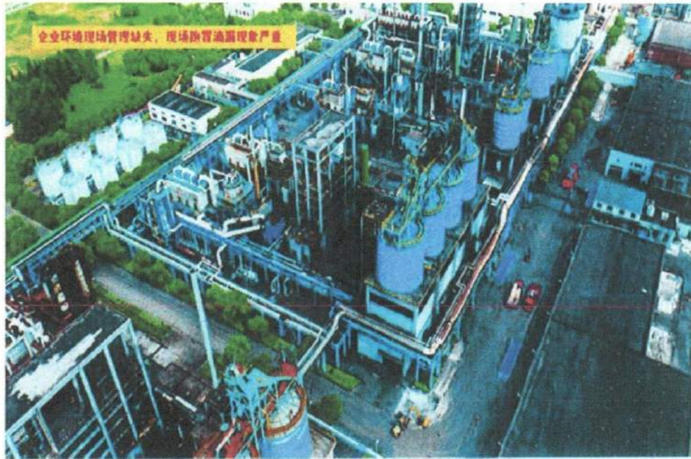
图 18、企业环境现场管理严重缺失，现场跑冒滴漏现象
