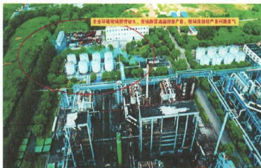
图 17、企业环境现场管理严重缺失，现场跑冒滴漏现象，现场疑似排放较严重废气
