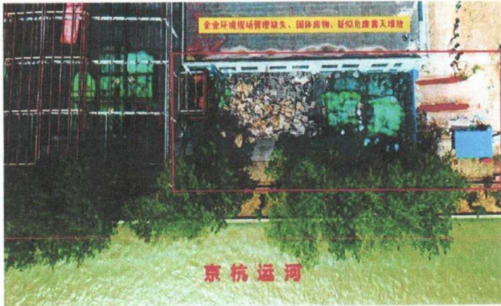
图 14、企业环境现场管理严重缺失，固体废物、疑似危废露天堆放
