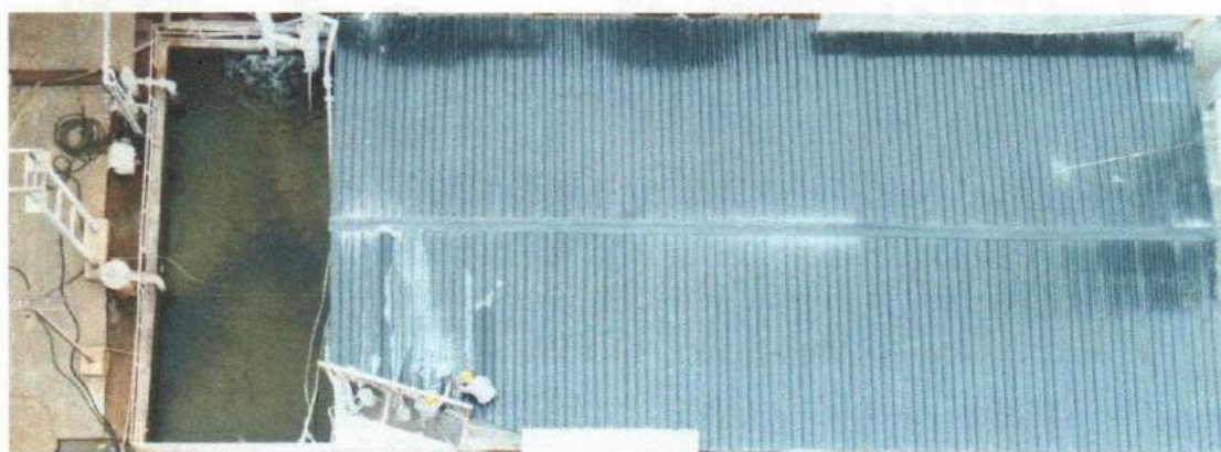
9月5日氢氧化钙储存池已完成加盖
