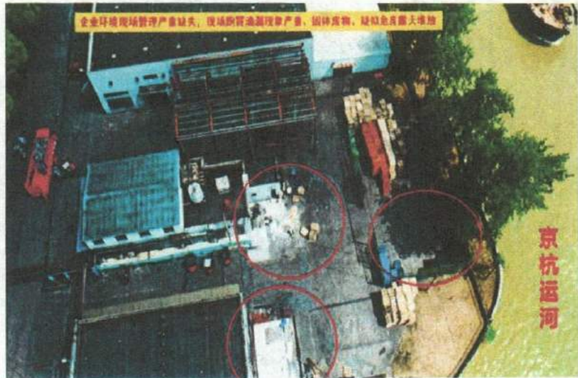
图 15、企业环境现场管理严重缺失，现场跑冒滴漏现象、固体废物、疑似危废露天堆放
