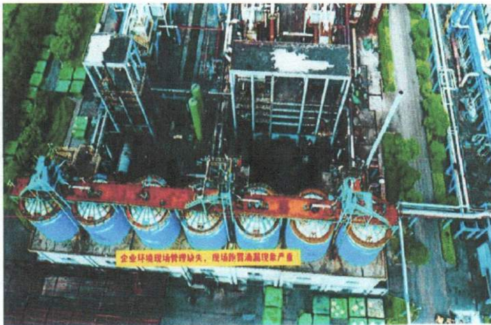
图 16、企业环境现场管理严重缺失，现场跑冒滴漏现象
