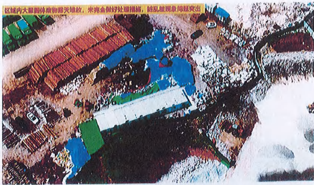
图 4、区域内大量固体废物露天堆放，未完全做好处理措施，脏乱差现象问题突出
