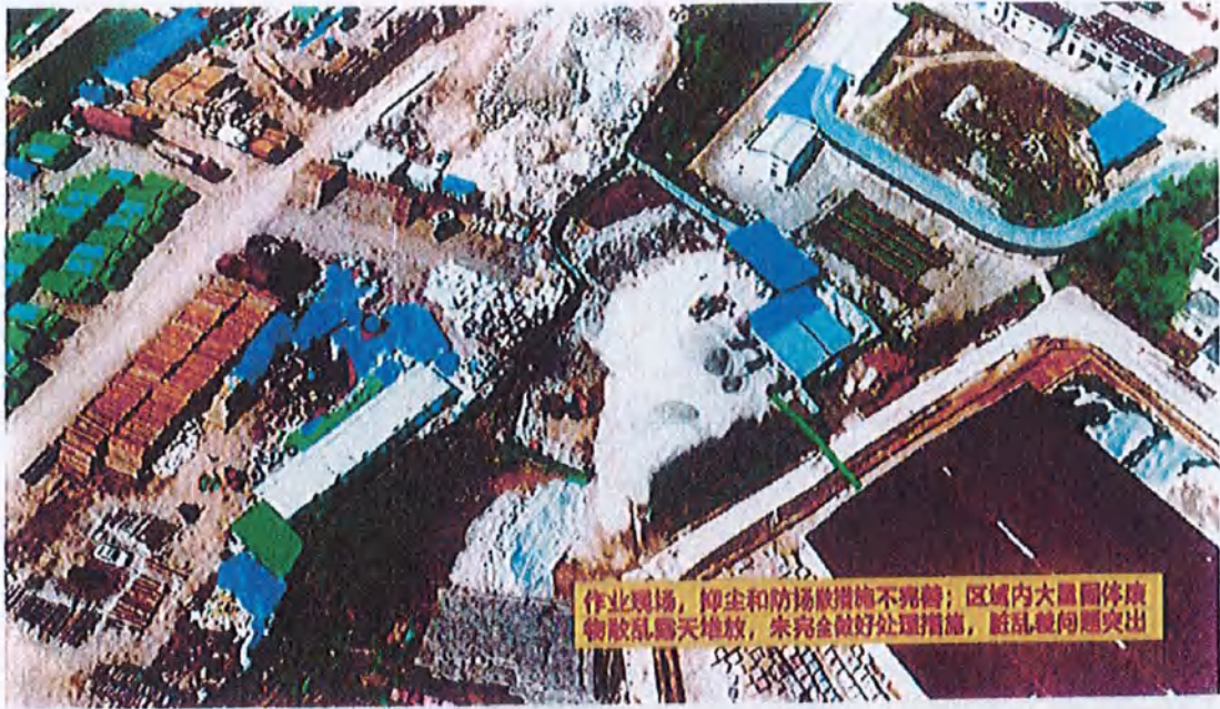
图 3、作业现场，抑尘和防扬尘措施不完善；区域内大量固体废物散乱露天堆放，未完全做好处理措施，脏乱差问题突出
