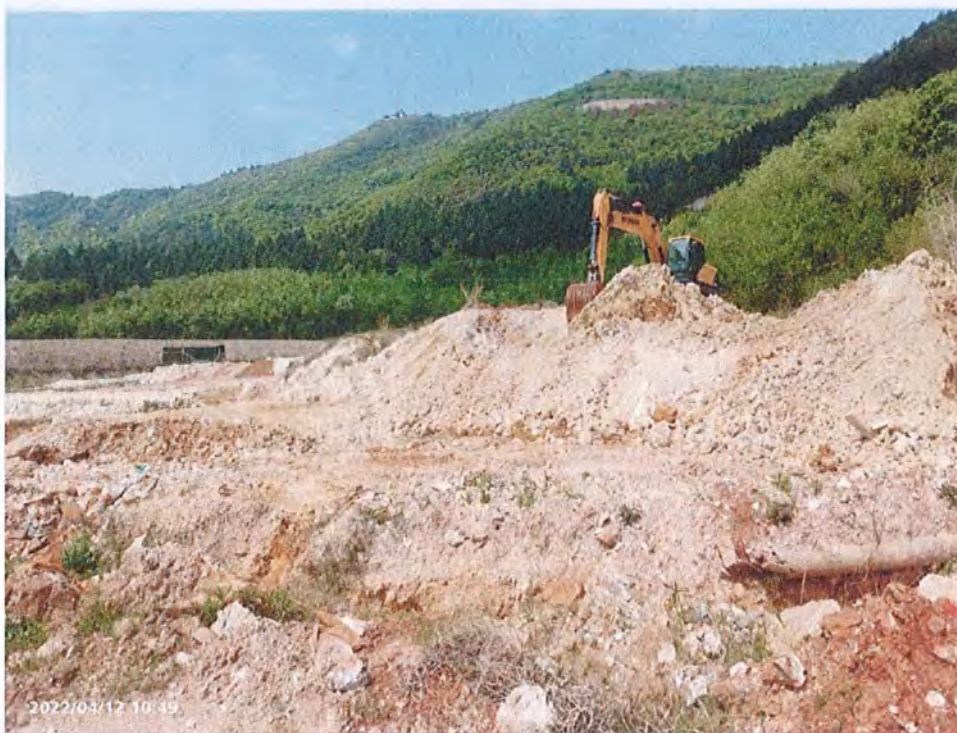
原矿堆场实拍图 3
