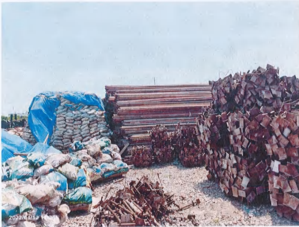
钢结构扣件堆放实拍图 1
