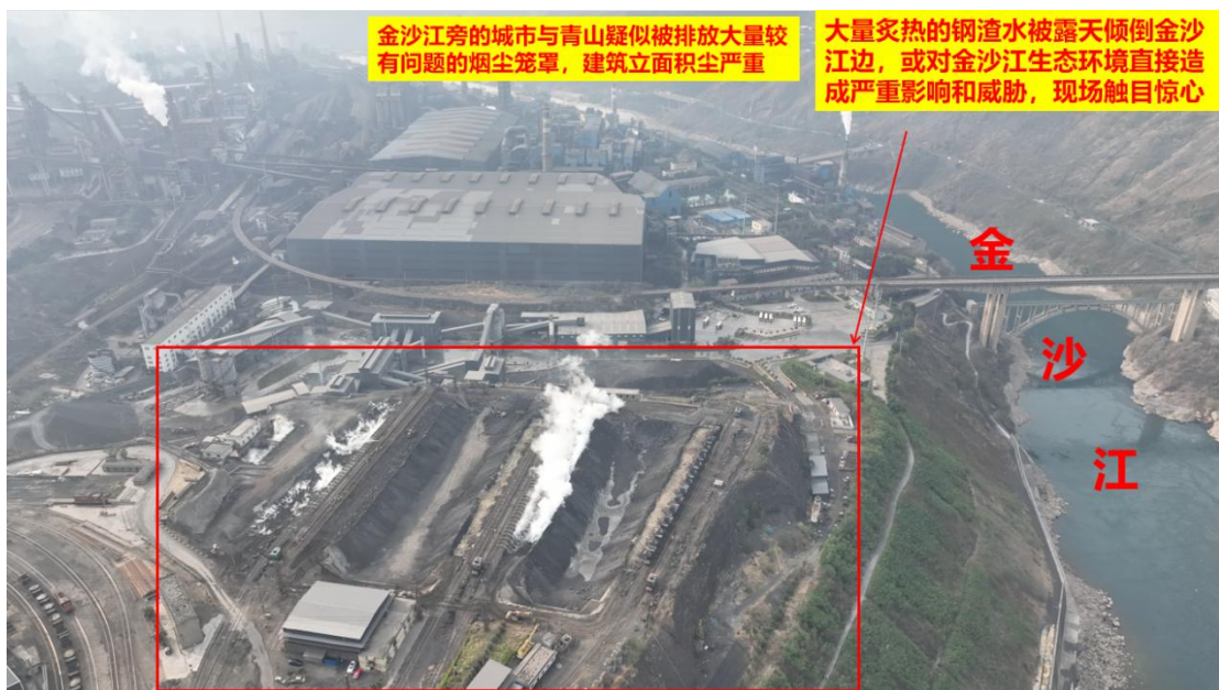
图 3、金沙江旁的城市与青山疑似被排放大量较有问题的烟尘笼罩，建筑立面积尘严重；大量炙热的钢渣水被露天倾倒金沙江边，或对金沙江生态环境直接造成严重影响和威胁，现场触目惊心
