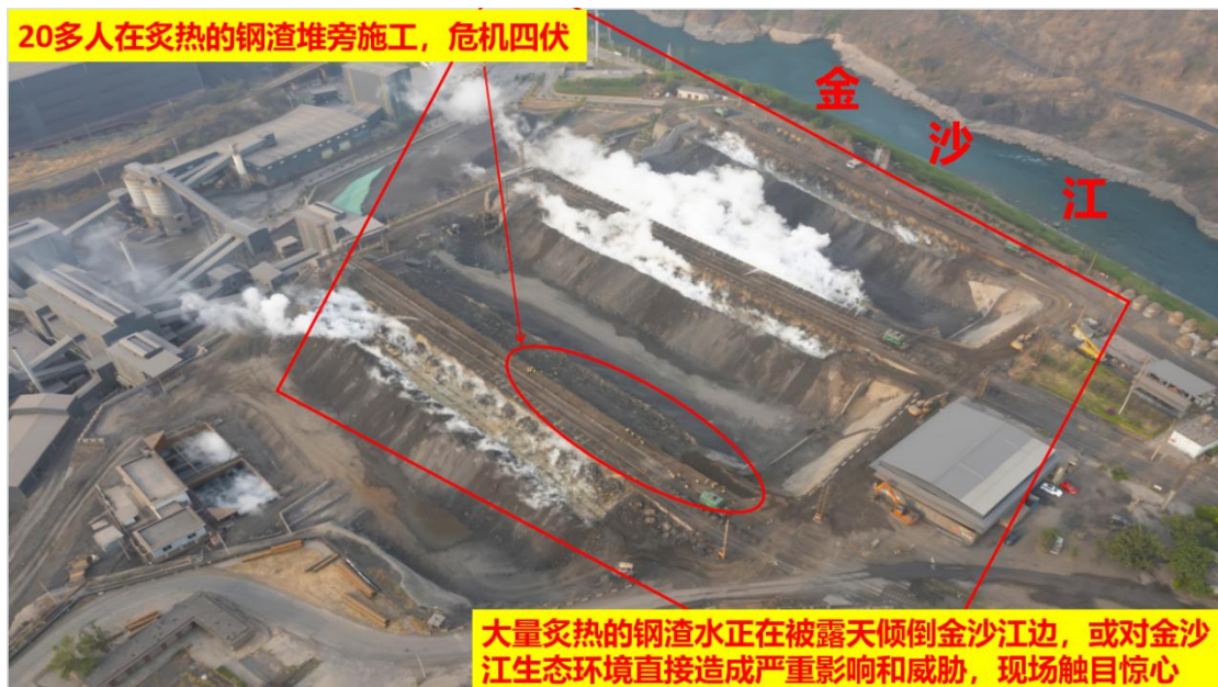
图 9、20 多人在炙热的钢渣堆旁施工，危机四伏。大量炙热的钢渣水正在被露天倾倒金沙江边，或对金沙江生态环境直接造成严重影响和威胁，现场触目惊心
