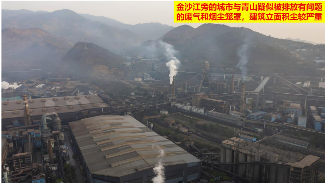
图 12、金沙江旁的城市与青山疑似被排放有问题的废气和烟尘笼罩， 建筑立面积尘较严重
