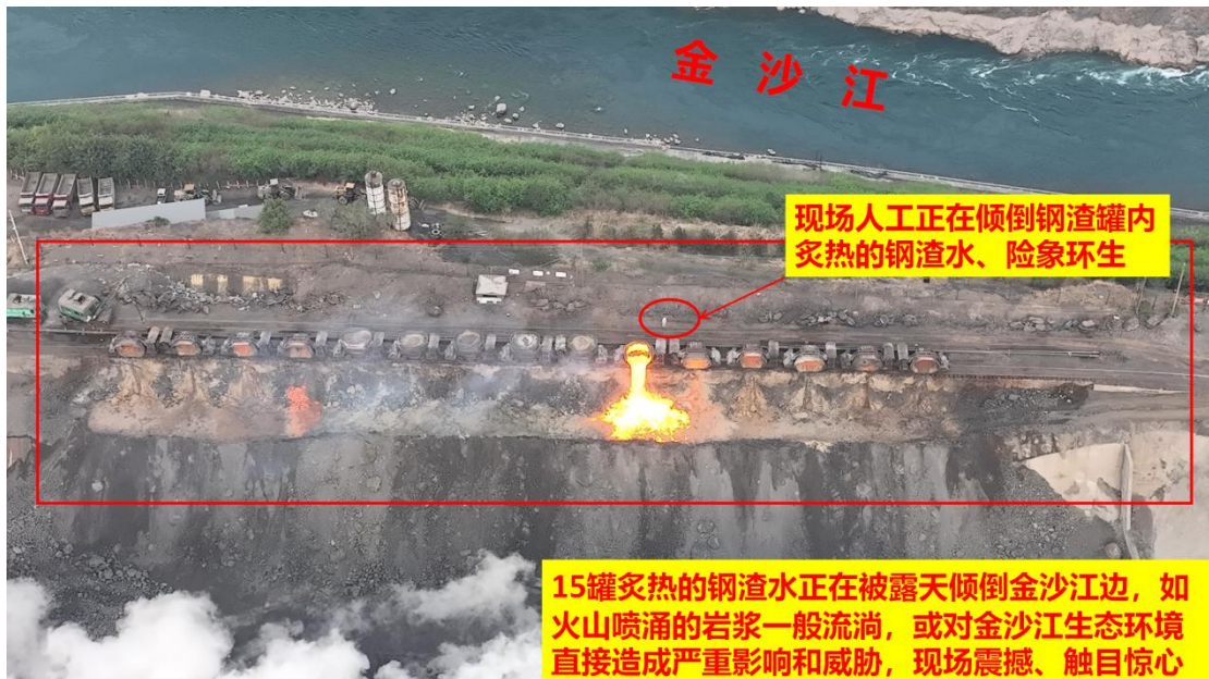
图 5、现场人工正在倾倒钢渣罐内炙热的钢渣水、险象环生！15 罐炙热的钢渣水正在被露天倾倒金沙江边，如火山喷涌的岩浆般流淌，或对金沙江生态环境直接造成严重影响和威胁，现场震撼、触目惊心
