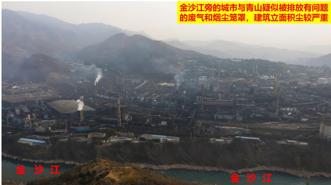
图 13、金沙江旁的城市与青山疑似被排放有问题的废气和烟尘笼罩， 建筑立面积尘较严重
