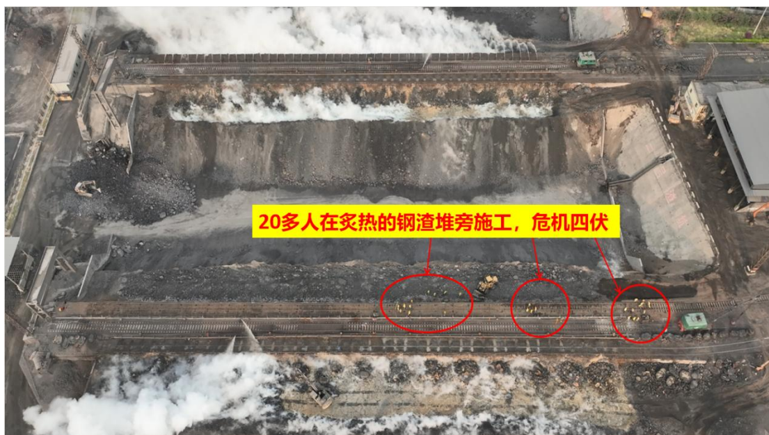
图 10、20 多人在炙热的钢渣堆旁施工，危机四伏
