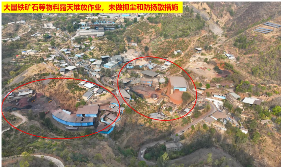
图 23、大量铁矿石等物料露天堆放作业，未做抑尘和防扬尘措施
