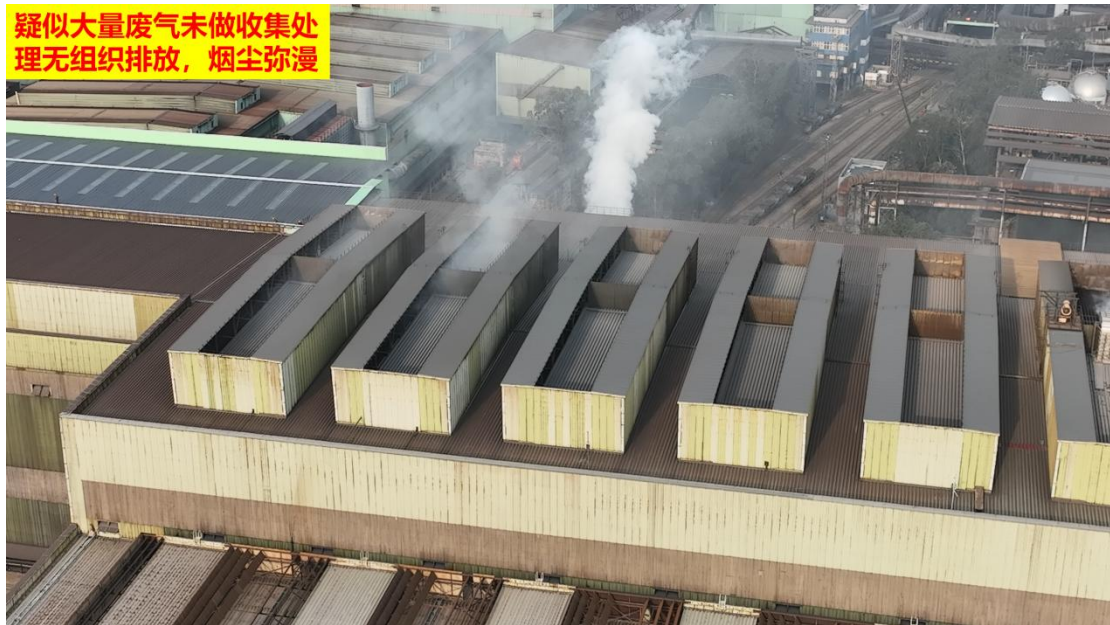
图 18、疑似大量废气未做收集处理无组织排放，烟尘弥漫
