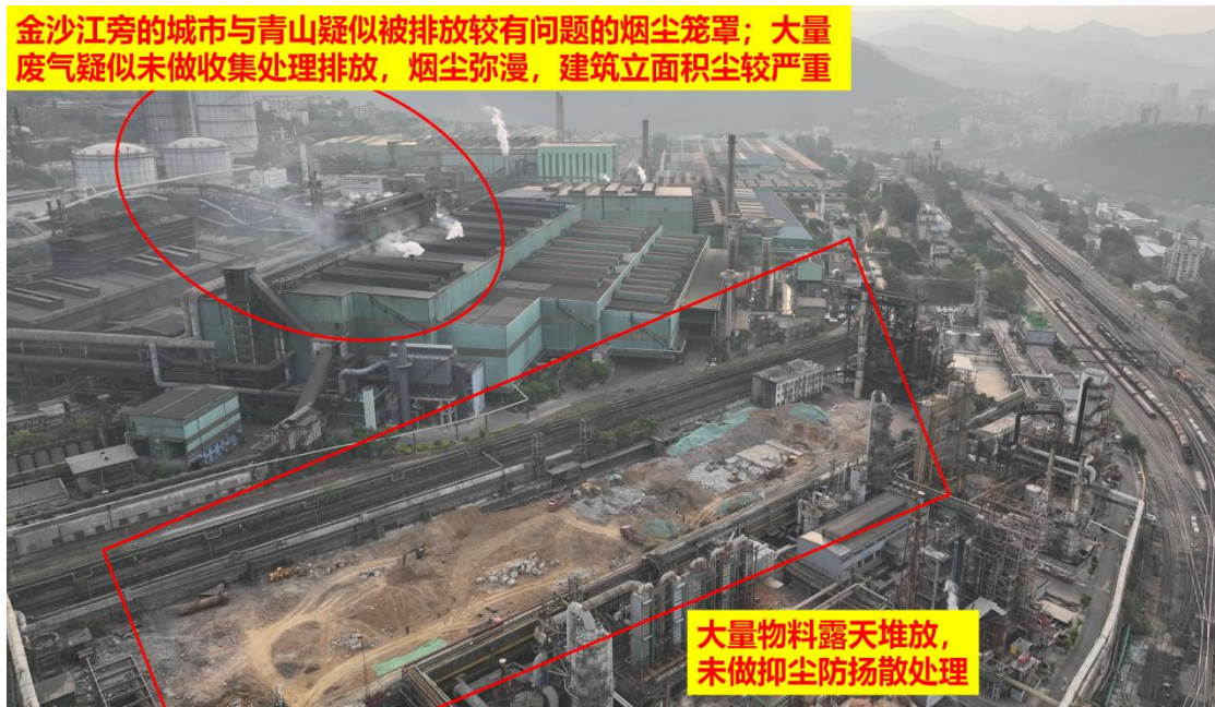
图 21、金沙江旁的城市与青山疑似被排放较有问题的烟尘笼罩；大量废气疑似未做收集处理排放，烟尘弥漫，建筑立面积尘较严重；大量物料露天堆放，未做抑尘防扬尘处理
