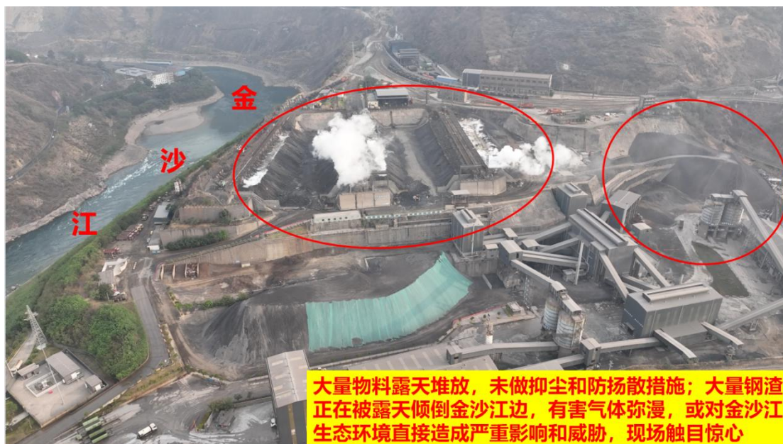
图 25、大量物料露天堆放作业，未做抑尘和防扬尘措施；大量钢渣正在被露天倾倒金沙江边，有问题热蒸汽气体弥漫，或对金沙江生态环境直接造成严重影响和威胁，现场触目惊心
