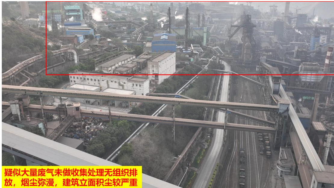
图 20、疑似大量废气未做收集处理无组织排放，烟尘弥漫，建筑立面积尘较严重
