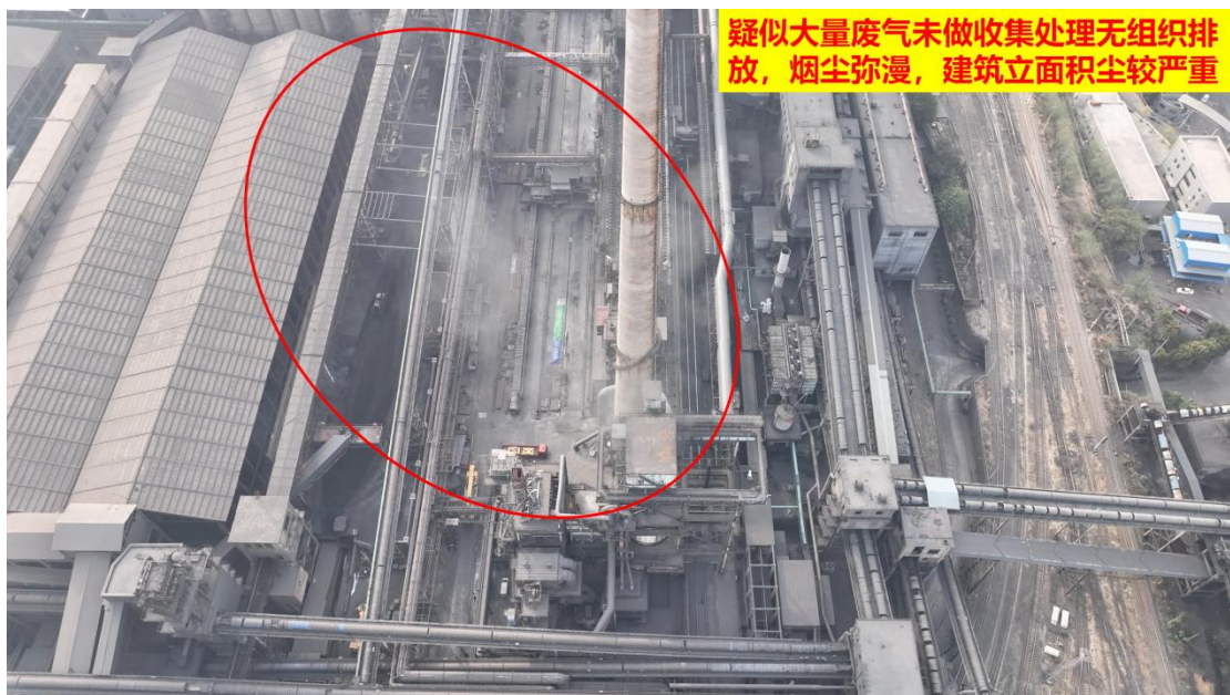
图 19、疑似大量废气未做收集处理无组织排放，烟尘弥漫，建筑立面积尘较严重
