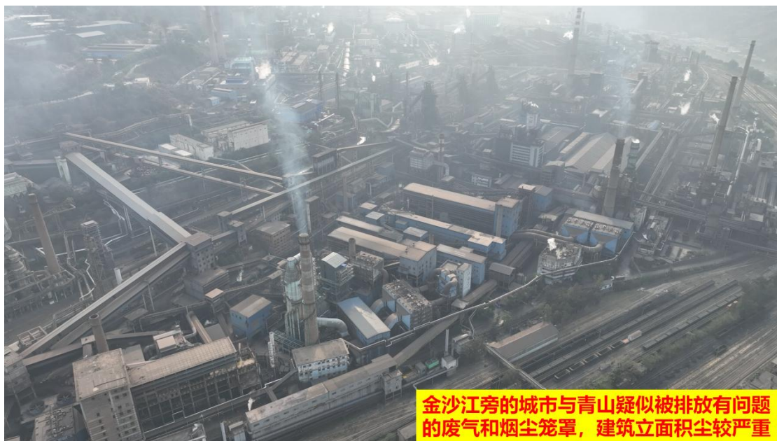
图 17、金沙江旁的城市与青山疑似被排放有问题的废气和烟尘笼罩， 建筑立面积尘较严重
