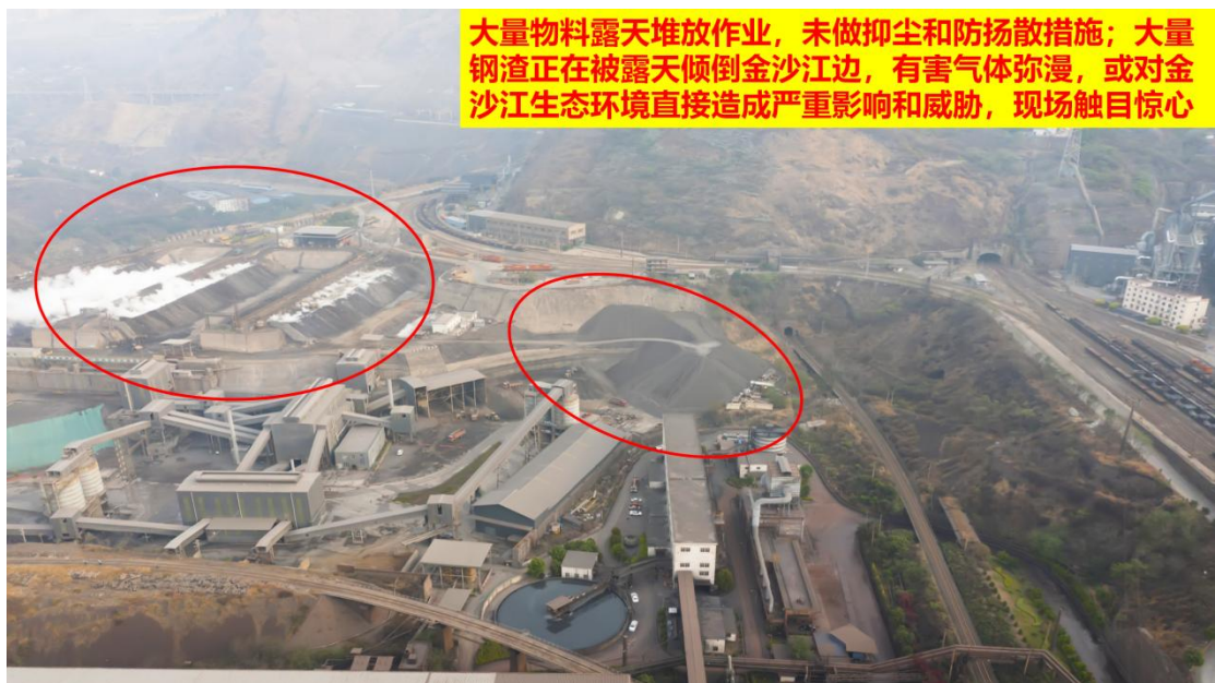
图 24、大量物料露天堆放作业，未做抑尘和防扬尘措施；大量钢渣正在被露天倾倒金沙江边，有问题热蒸汽气体弥漫，或对金沙江生态环境直接造成严重影响和威胁，现场触目惊心
