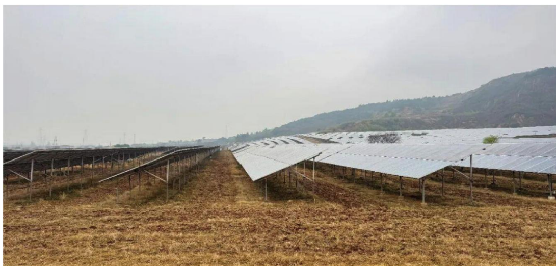
图 4-7 溧阳埭头镇农光互补光伏发电项目——板下土地已完成全面平整整治
