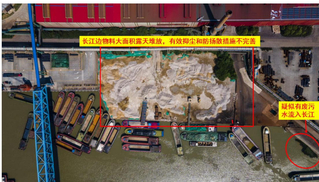
图 22、长江边物料大面积露天堆放，抑尘和防扬尘措施不完善；疑似有废污水流入长江
