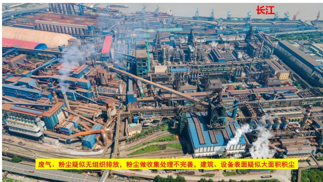
图 8、废气、粉尘疑似无组织排放，粉尘做收集处理不完善，建筑、设备表面疑似大面积积尘
