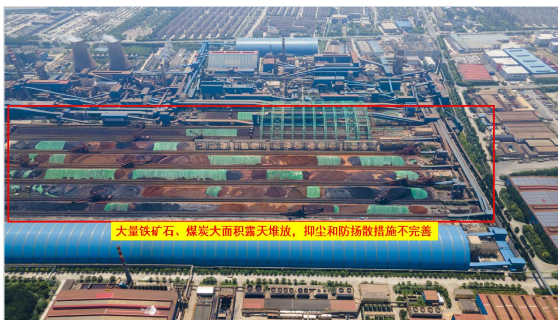
图 28、大量铁矿石、煤炭大面积露天堆放，抑尘和防扬尘措施不完善
