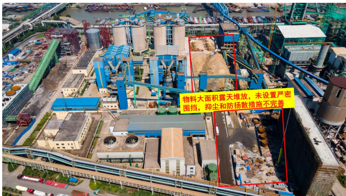
图 21、物料大面积露天堆放，抑尘和防扬尘措施不完善
