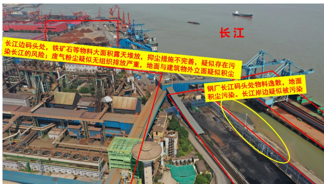
图 41、长江边码头处，铁矿石等物料大面积露天堆放，抑尘措施不完善，疑似存在污染长江的风险；废气粉尘疑似无组织排放严重，地面与建筑物外立面疑似积尘
