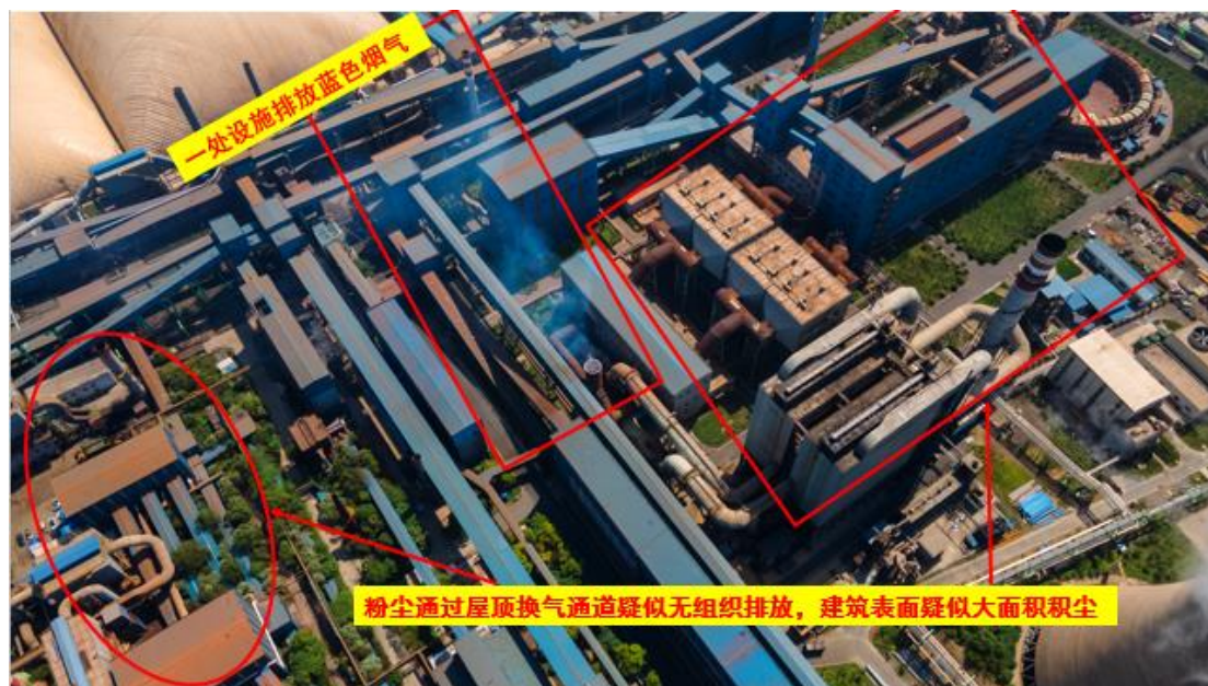
图 4、一处设施排放蓝色烟气，粉尘通过屋顶换气通道疑似无组织排放，建筑表面疑似大面积积尘
