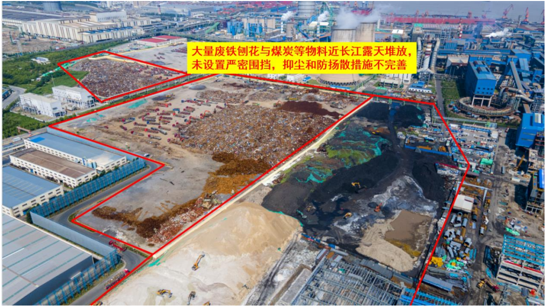
图 16、大量废铁刨花与煤炭等物料近长江露天堆放，未设置严密围挡，抑尘和防扬尘措施不完善
