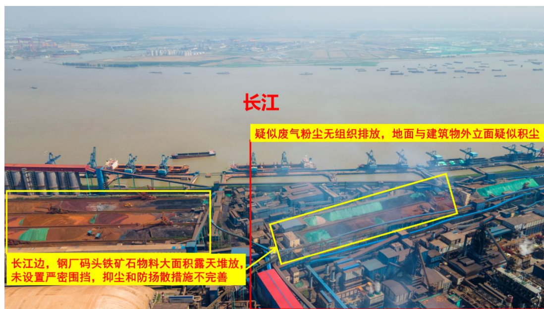
图 33、长江边，铁矿石等物料大面积露天堆放，抑尘防扬尘措施不完善；疑似废气粉尘无组织排放，地面与建筑物外立面疑似积尘
