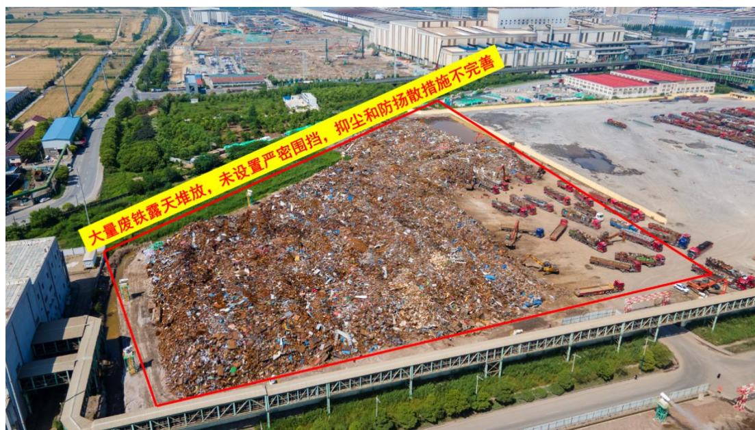
图 20、大量废铁露天堆放，抑尘和防扬尘措施不完善
