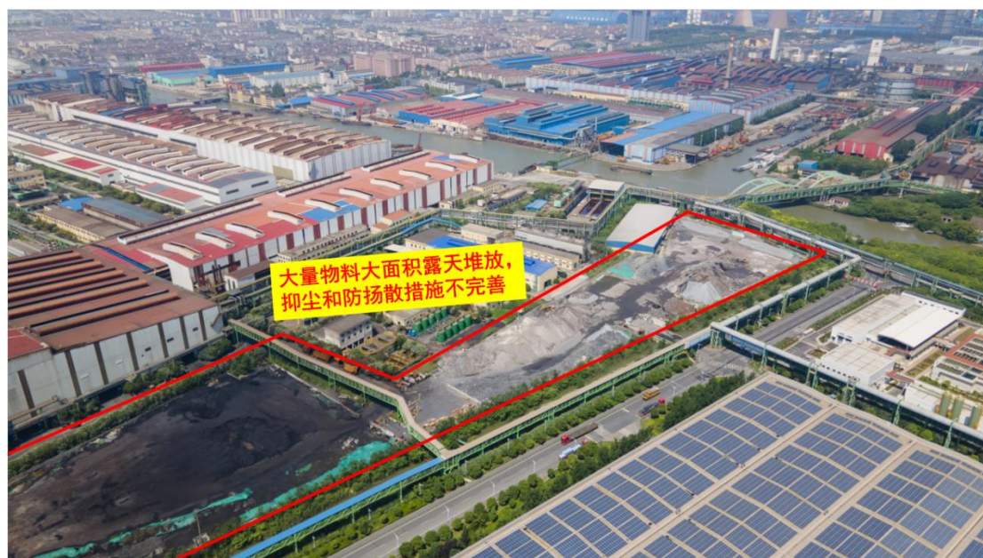
图 26、大量物料大面积露天堆放，抑尘和防扬尘措施不完善
