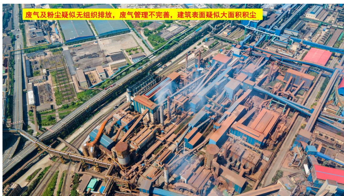
图 11、废气及粉尘疑似无组织排放，废气管理不完善，建筑表面疑似大面积积尘
