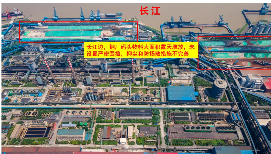
图 39、长江边码头处，物料大面积露天堆放，抑尘防扬尘措施不完善
