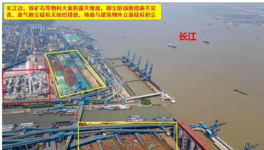
图 36、长江边，铁矿石等物料大面积露天堆放，抑尘防扬尘措施不完善，废气粉尘疑似无组织排放，地面与建筑物外立面疑似积尘
