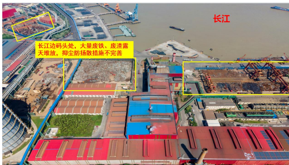
图 32、长江边码头处，大量废铁、废渣露天堆放，抑尘防扬尘措施不完善
