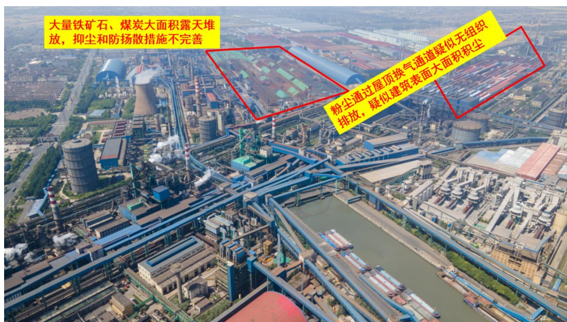
图 9、废气、粉尘通过屋顶换气通道疑似无组织排放，疑似建筑表面大面积积尘。大量铁矿石、煤炭大面积露天堆放，抑尘和防扬尘措施不完善
