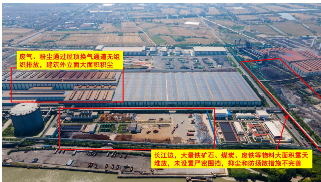
图 25、长江边，大量铁矿石、煤炭、废铁等物料大面积露天堆放，抑尘和防扬尘措施不完善。废气、粉尘疑似通过屋顶换气通道无组织排放，建筑外立面疑似大面积积尘
