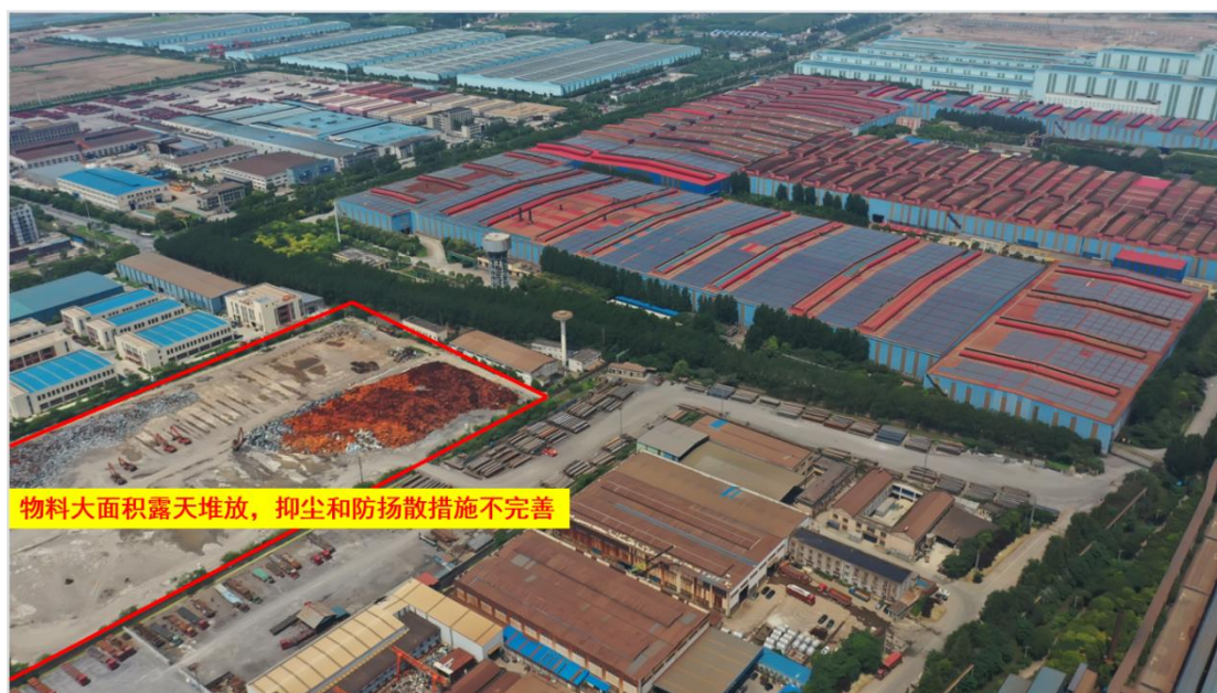
图 29、物料大面积露天堆放，抑尘和防扬尘措施不完善
