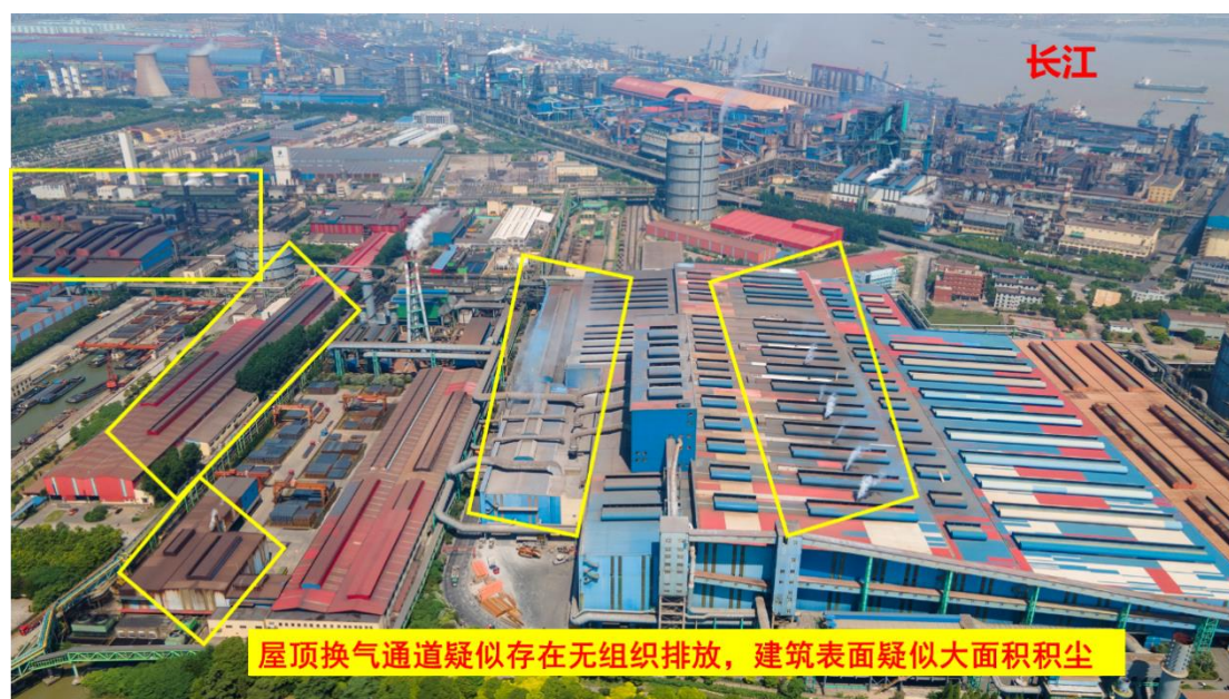
图 5、屋顶换气通道疑似存在无组织排放，建筑表面疑似大面积积尘
