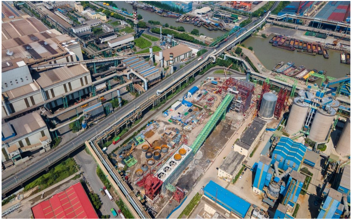
图 14、在建的全封闭料仓及输送装置
