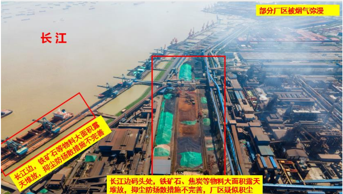
图 31、长江边码头处，铁矿石、焦炭等物料大面积露天堆放，抑尘防扬散措施不完善，厂区设施和建筑疑似积尘，部分厂区被烟气弥漫
