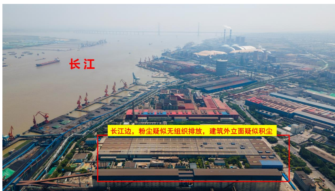
图 37、长江边，粉尘疑似无组织排放，建筑外立面疑似积尘
