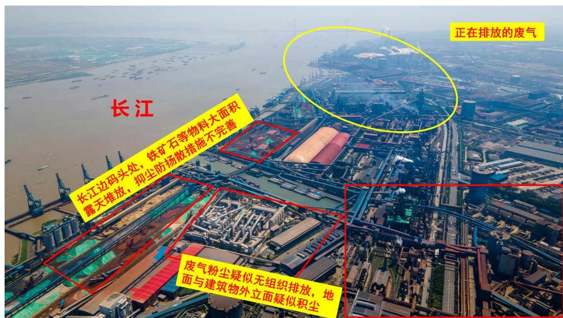
图 38、长江边码头处，铁矿石等物料大面积露天堆放，抑尘防扬尘措施不完善，废气粉尘疑似无组织排放，地面与建筑物外立面疑似积尘
