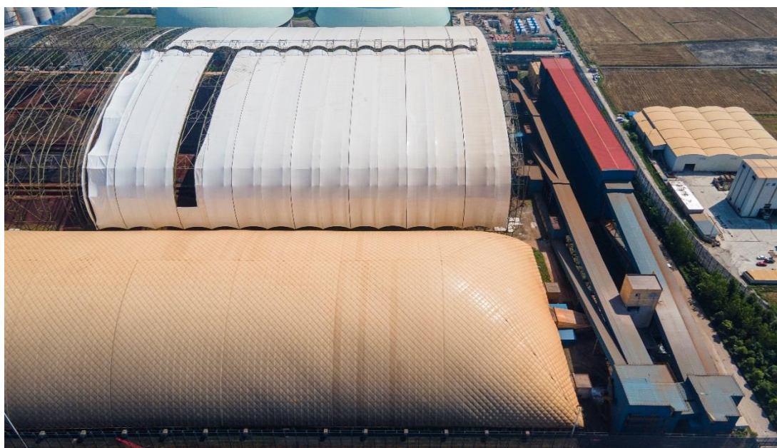
图 13、在建与已投入使用的全封闭气膜料仓
