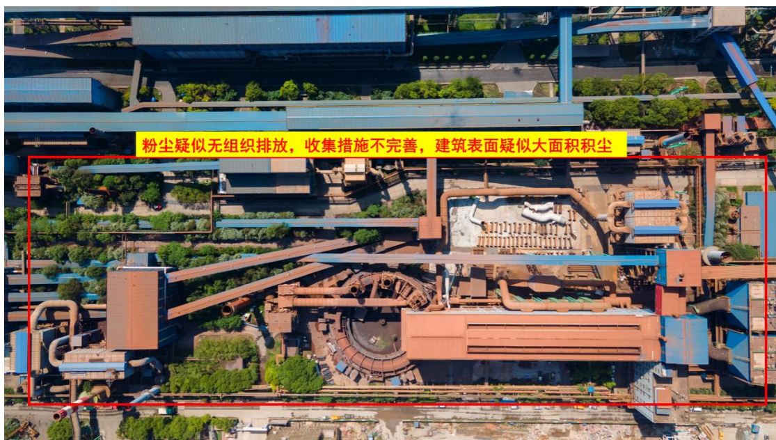
图 7、粉尘疑似无组织排放，收集措施不完善，建筑表面疑似大面积积尘
