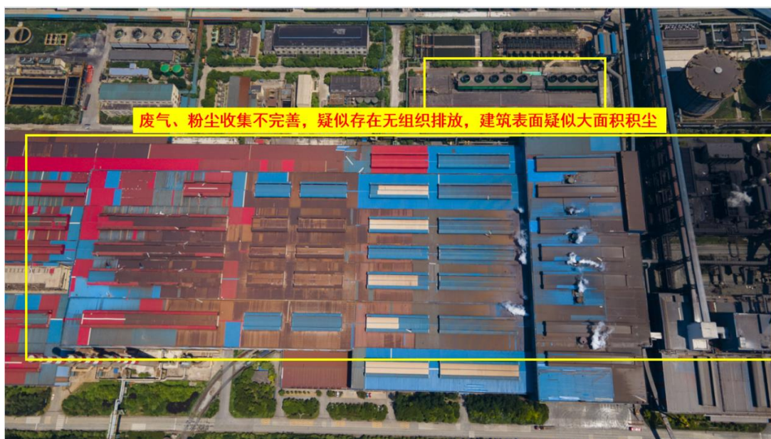
图 12、废气、粉尘收集不完善，疑似存在无组织排放，建筑表面疑似大面积积尘
