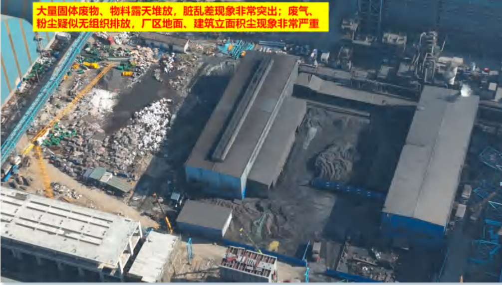
大量物料露天堆放，未设置严密围挡，未做抑尘和防扬尘措施
