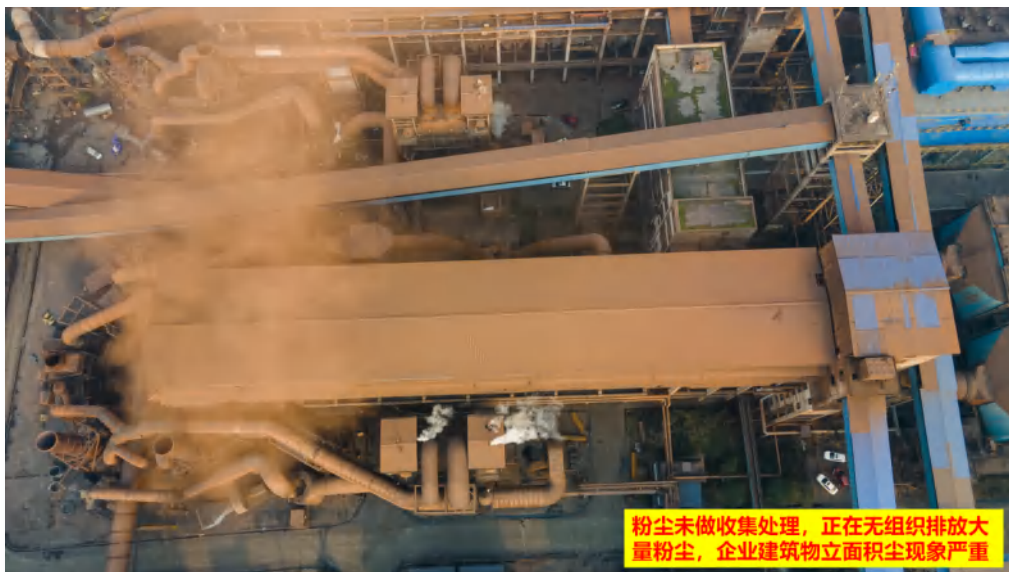
企业建筑物立面面积尘现象严重；废气粉尘未做有效收集处理，周围居民小区生活环境疑似受到较大影响
