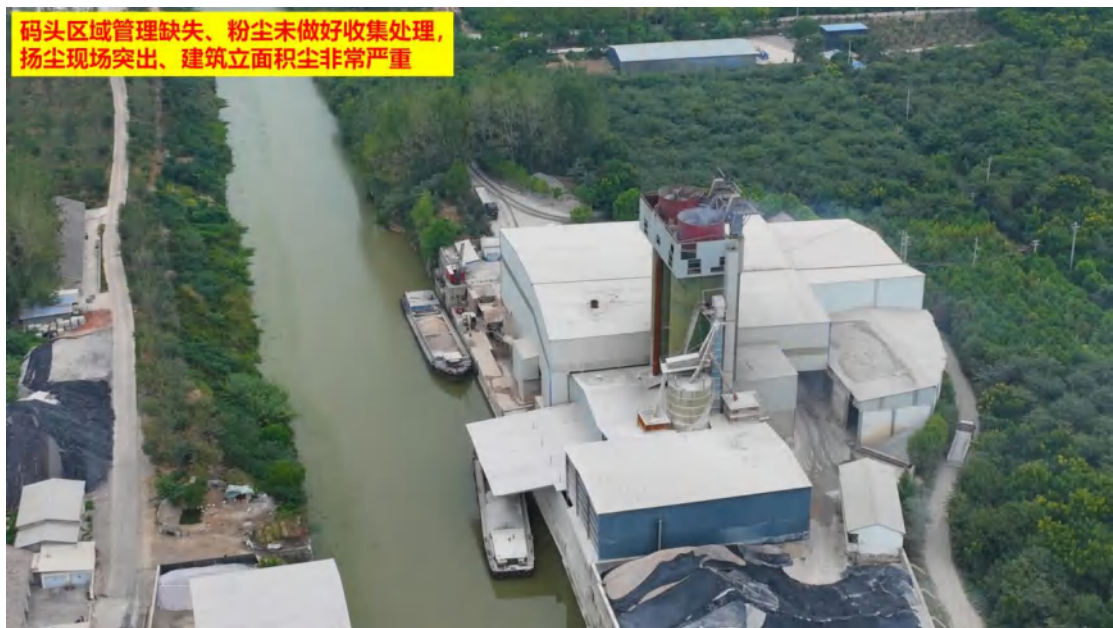
图 43、码头区域管理缺失、粉尘未做好收集处理，扬尘现场突出、建筑立面面积尘非常严重
