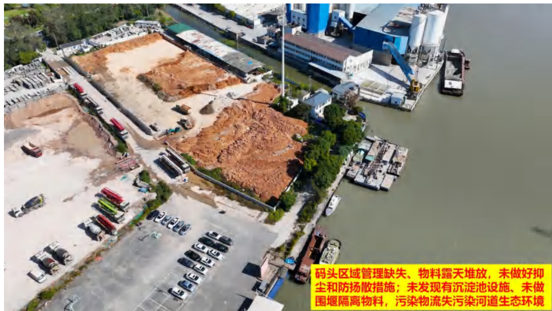
图 17、码头区域管理缺失、物料露天堆放，未做好抑尘和防扬尘措施；未发现有沉淀池设施、未做围堰隔离物料，污染物流失污染河道生态环境
