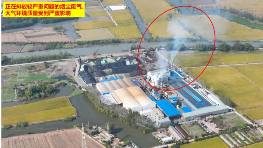
图 59、正在排放较严重问题的烟尘废气，大气环境质量受到严重影响
