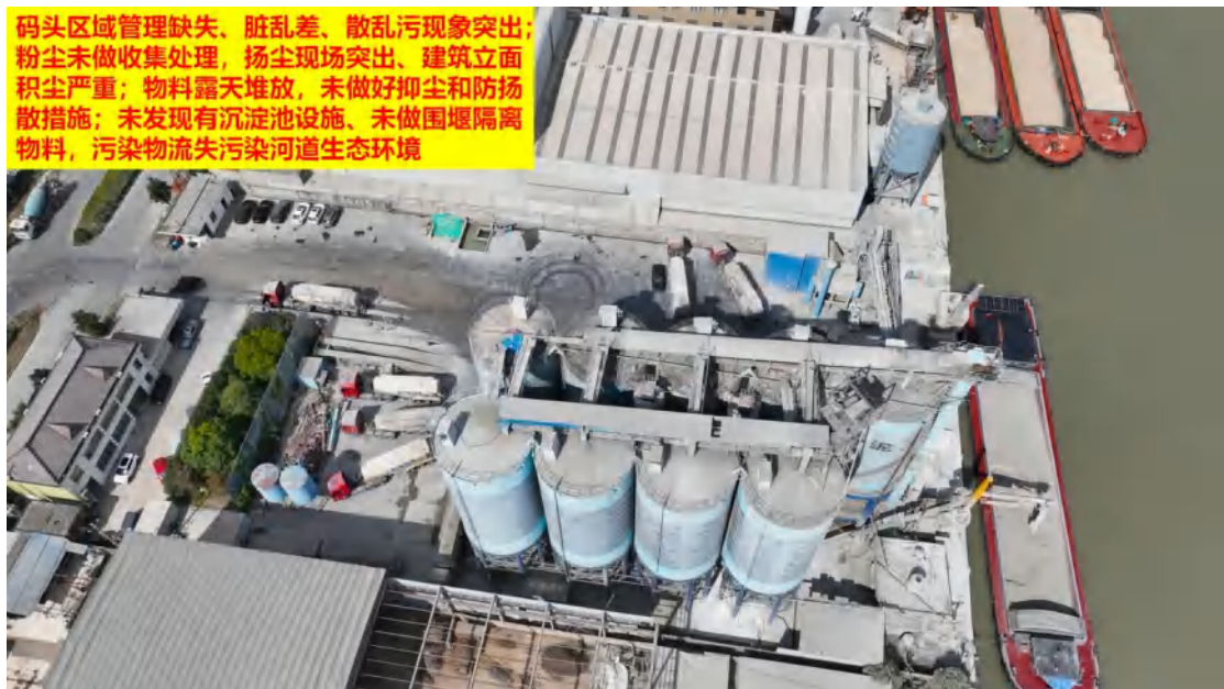
图 39、码头区域管理缺失、脏乱差、散乱污现象突出；粉尘未做收集处理，扬尘现场突出、建筑立面积尘严重；物料露天堆放，未做好抑尘和防扬尘措施；未发现有沉淀池设施、未做围堰隔离物料，污染物流失污染河道生态环境
