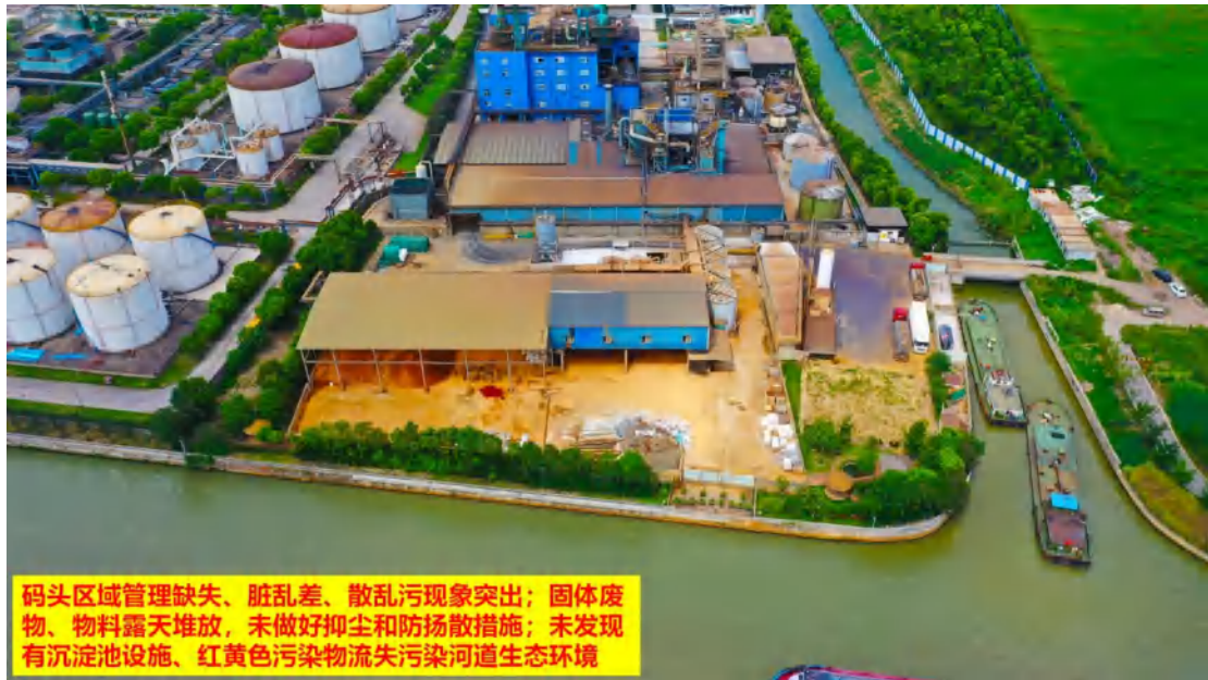
图 8、码头区域管理缺失、脏乱差、散乱污现象突出；固体废物、物料露天堆放，未做好抑尘和防扬散措施；未发现有沉淀池设施、红黄色污染物布满建筑立面和场地后流失河道污染生态环境
