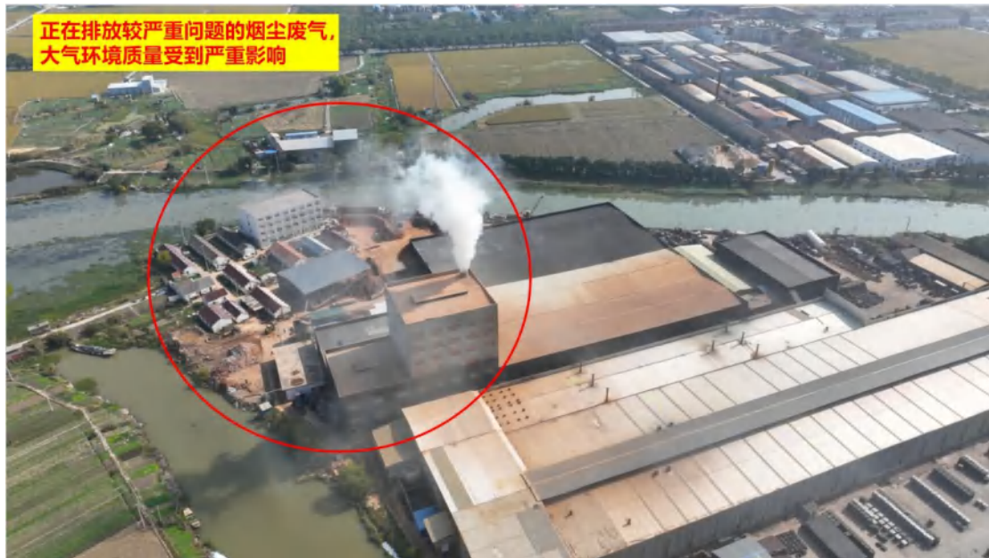
图 61、正在排放较严重问题的烟尘废气，大气环境质量受到严重影响
