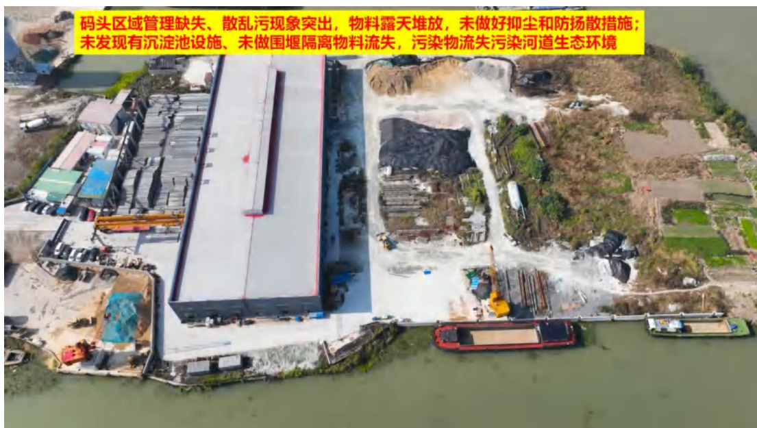
图 14、码头区域管理缺失、散乱污现象突出，物料露天堆放，未做好抑尘和防扬散措施；未发现有沉淀池设施、未做围堰隔离物料流失，污染物流失污染河道生态环境
