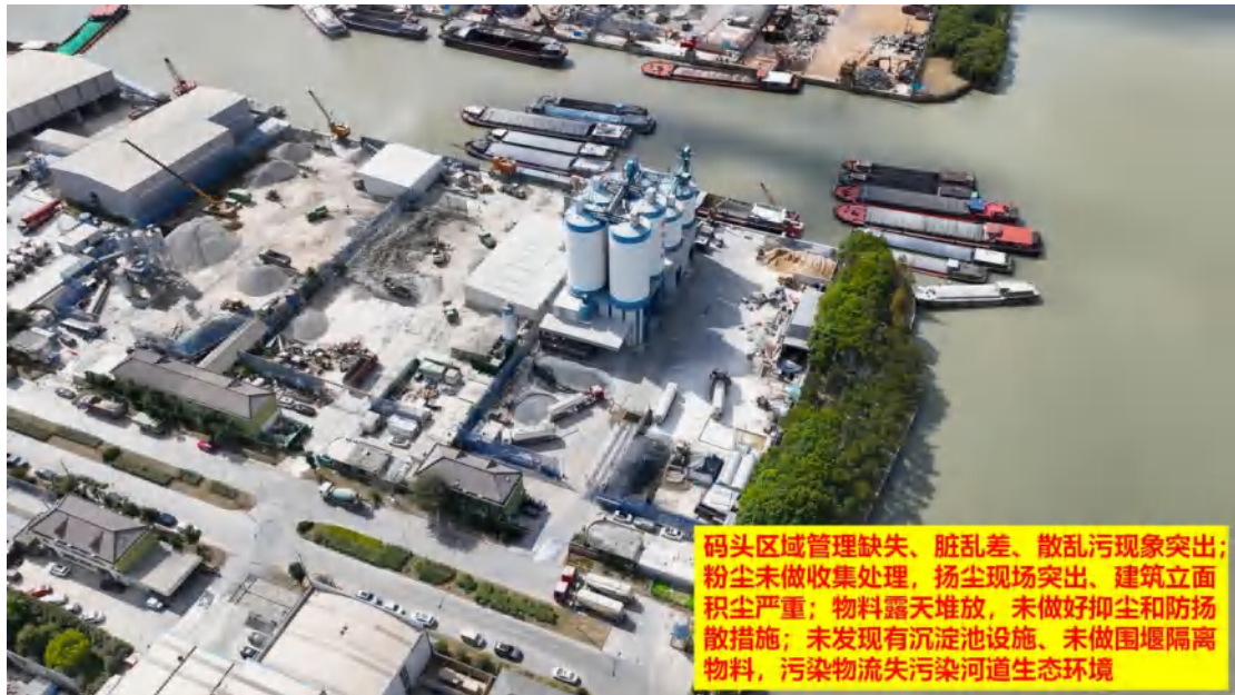
图 30、码头区域管理缺失、脏乱差、散乱污现象突出；粉尘未做收集处理，扬尘现场突出、建筑立面积尘严重；物料露天堆放，未做好抑尘和防扬尘措施；未发现有沉淀池设施、未做围堰隔离物料，污染物流失污染河道生态环境
