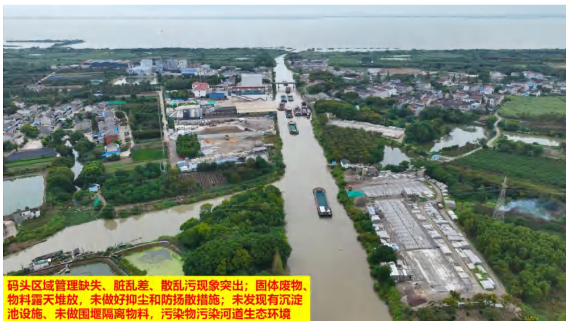
图 10、码头区域管理缺失、脏乱差、散乱污现象突出；固体废物、物料露天堆放，未做好抑尘和防扬散措施；未发现有沉淀池设施、未做围堰隔离物料，污染物流失污染河道生态环境
