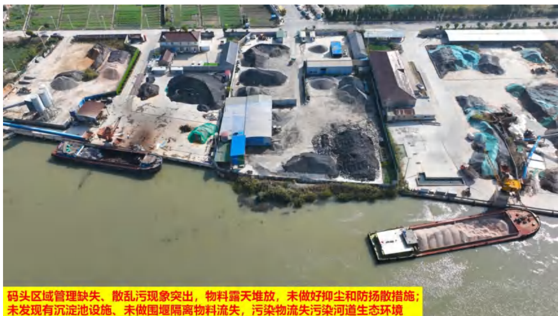
图 13、码头区域管理缺失、散乱污现象突出，物料露天堆放，未做好抑尘和防扬散措施；未发现有沉淀池设施、未做围堰隔离物料流失，污染物流失污染河道生态环境
