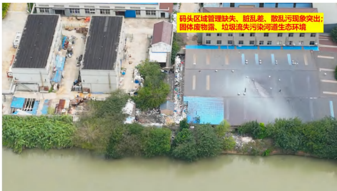
图 27、码头区域管理缺失、脏乱差、散乱污现象突出；固体废物露天堆放，污染物流失污染河道生态环境
