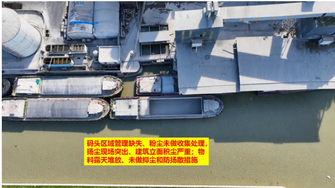
图 40、码头区域管理缺失、粉尘未做收集处理，扬尘现场突出、建筑立面积尘严重；物料露天堆放、未做抑尘和防扬尘措施
