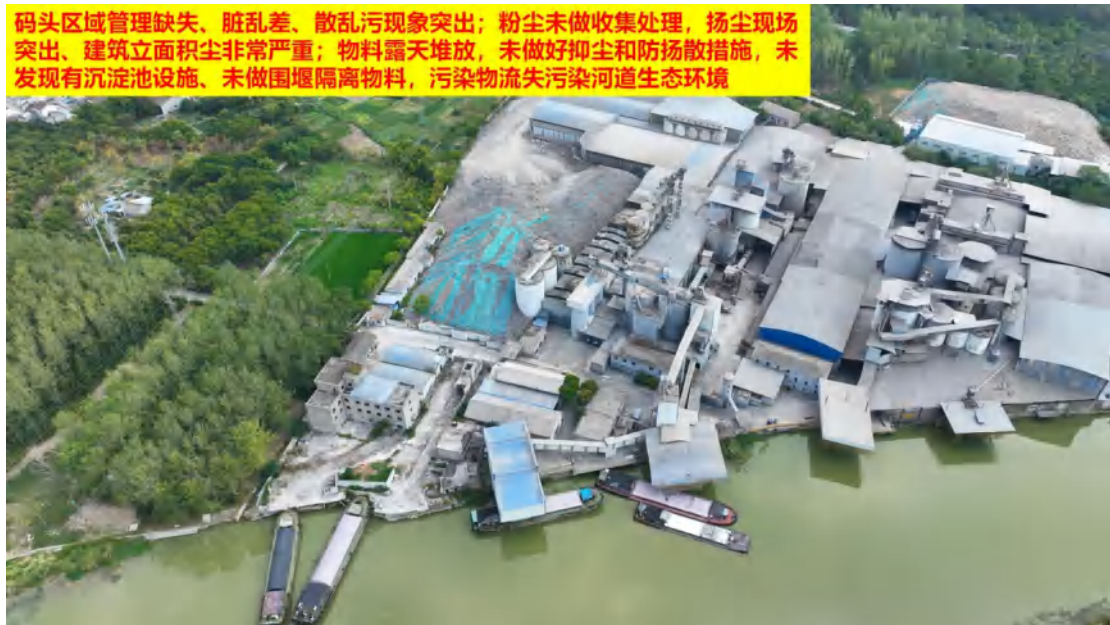
图 46、码头区域管理缺失、脏乱差、散乱污现象突出；粉尘未做收集处理，扬尘现场突出、建筑立面积尘非常严重；物料露天堆放，未做好抑尘和防扬尘措施，未发现有沉淀池设施、未做围堰隔离物料，污染物流失污染河道生态环境
