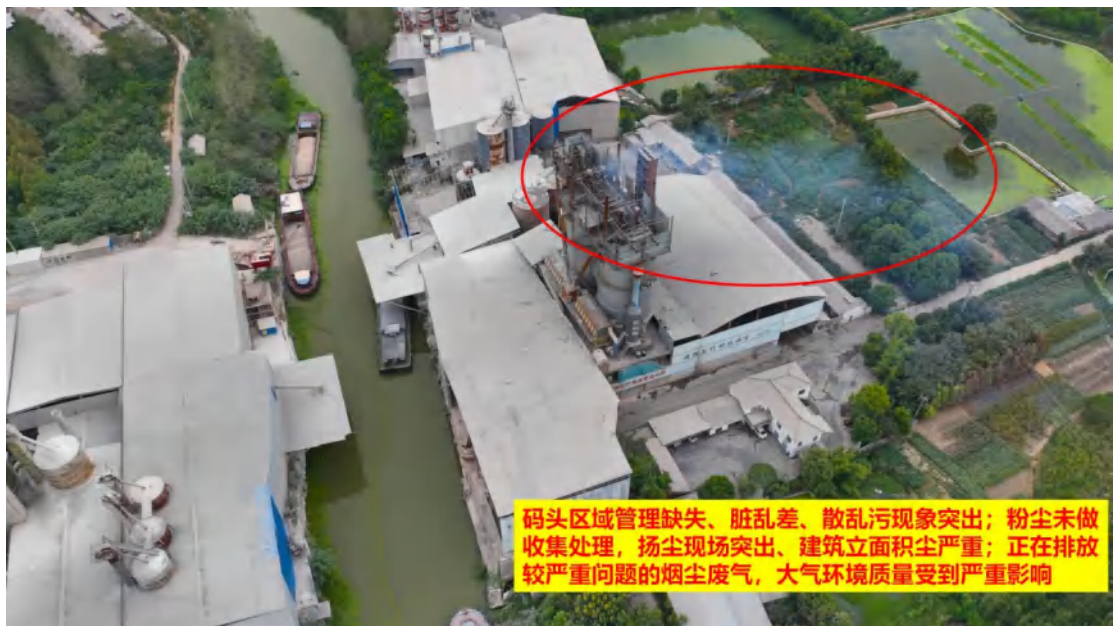
图 56 码头区域管理缺失、脏乱差、散乱污现象突出；粉尘未做收集处理，扬尘
