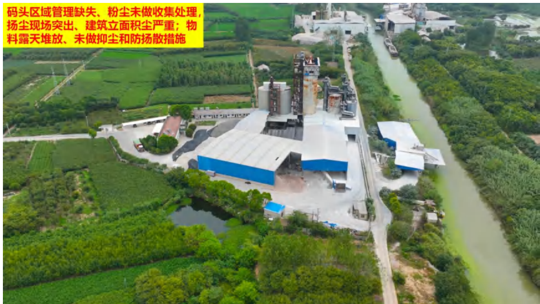
图 41、码头区域管理缺失、粉尘未做收集处理，扬尘现场突出、建筑立面积尘严重；物料露天堆放、未做抑尘和防扬尘措施
