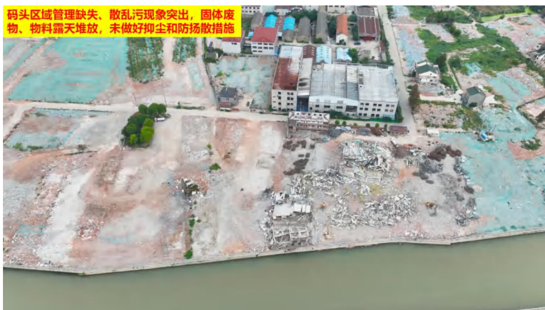
图 6、码头区域管理缺失、散乱污现象突出，固体废物、物料露天堆放，未做好抑尘和防扬尘措施
