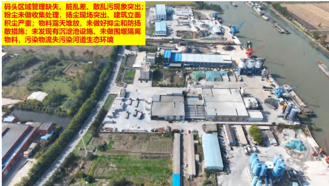
图 15、码头区域管理缺失、脏乱差、散乱污现象突出；粉尘未做收集处理，扬尘现场突出、建筑立面面积尘严重；物料露天堆放，未做好抑尘和防扬尘措施；未发现有沉淀池设施、未做围堰隔离物料，污染物流失污染河道生态环境
