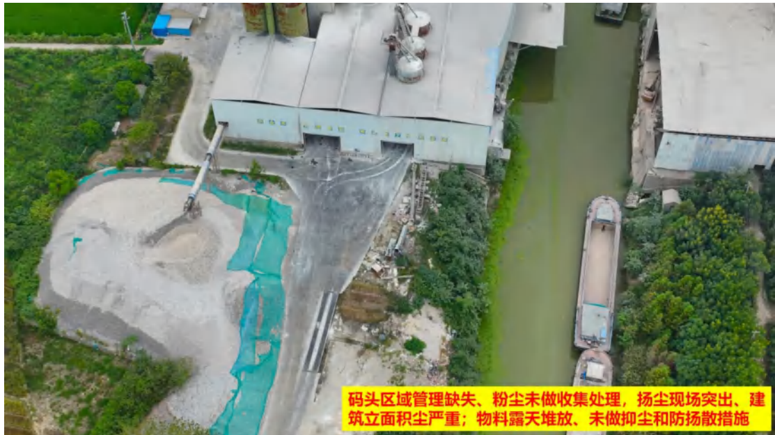
图 42、码头区域管理缺失、粉尘未做收集处理，扬尘现场突出、建筑立面面积尘严重；物料露天堆放、未做抑尘和防扬尘措施
