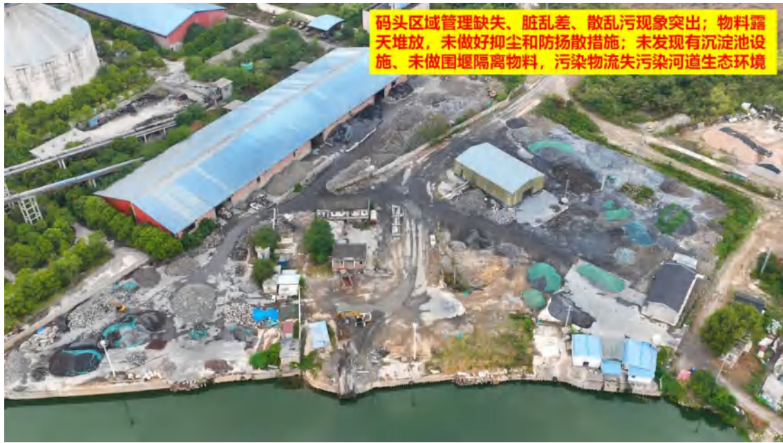
图 20、码头区域管理缺失、脏乱差、散乱污现象突出；物料露天堆放，未做好抑尘和防扬尘措施；未发现有沉淀池设施、未做围堰隔离物料，污染物流失污染河道生态环境
