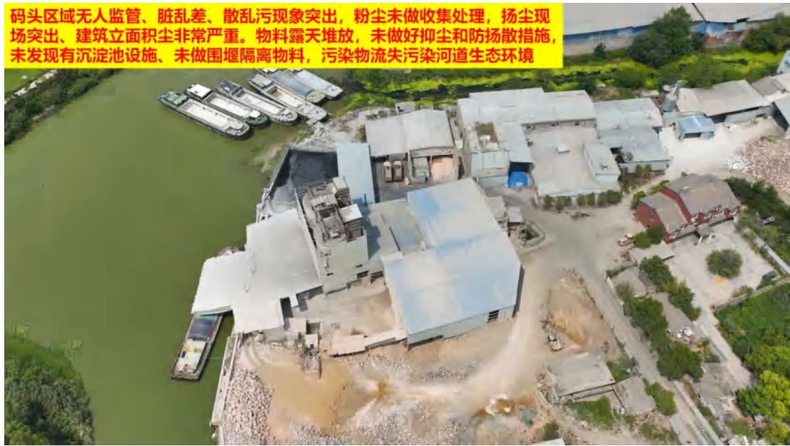
图 38、码头区域无人监管、脏乱差、散乱污现象突出，粉尘未做收集处理，扬尘现场突出、建筑立面积尘非常严重。物料露天堆放，未做好抑尘和防扬尘措施，未发现有沉淀池设施、未做围堰隔离物料，污染物流失污染河道生态环境
