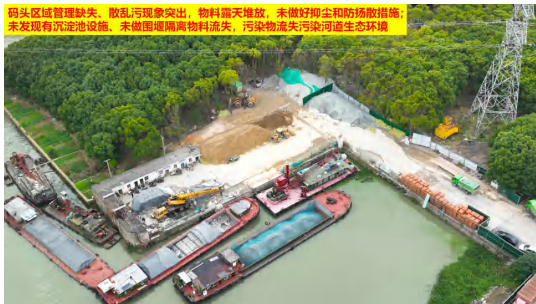
图 12、码头区域管理缺失、散乱污现象突出，物料露天堆放，未做好抑尘和防扬散措施；未发现有沉淀池设施、未做围堰隔离物料流失，污染物流失污染河道生态环境
