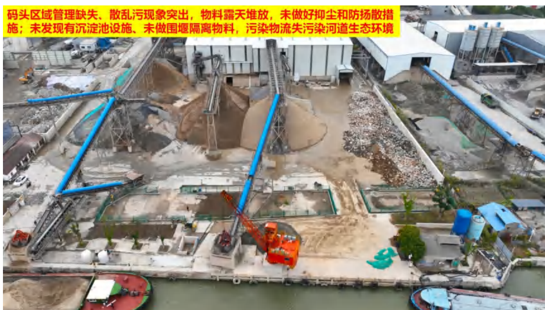
图 11、码头区域管理缺失、散乱污现象突出，物料露天堆放，未做好抑尘和防
