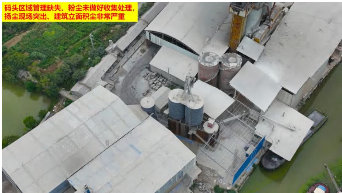
图 37 码头区域管理缺失、粉尘未做好收集处理，扬尘现场突出、建筑立面积尘非常严重
