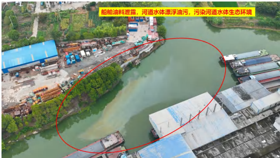
图 52、船舶油料泄露，河道水体漂浮油污，污染河道水体生态环境
