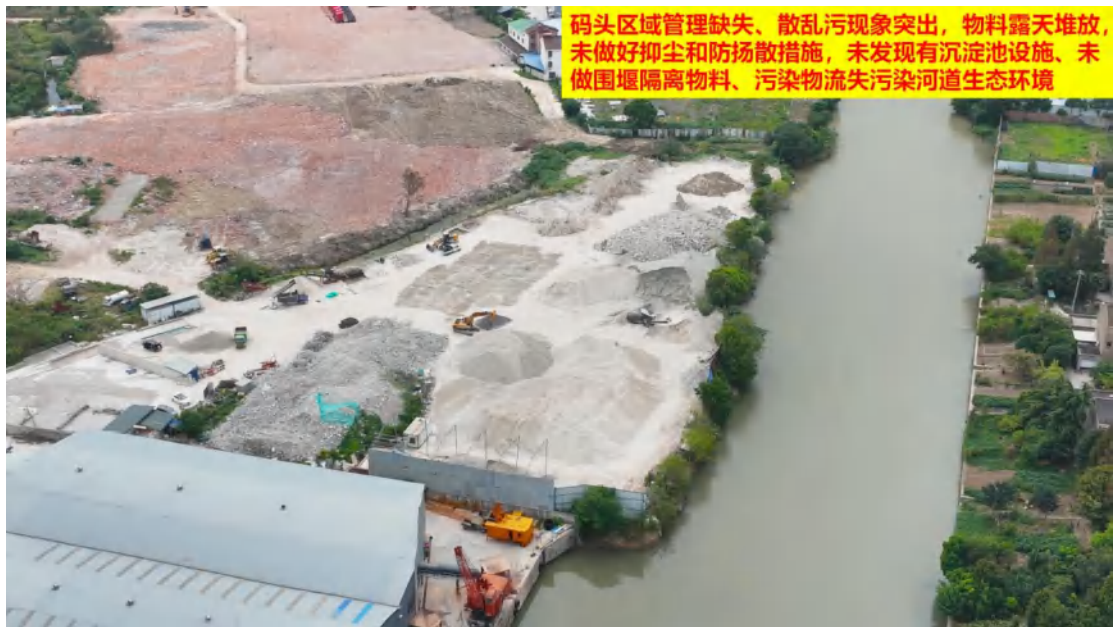
图 2、码头区域管理缺失、散乱污现象突出，物料露天堆放，未做好抑尘和防扬尘措施，未发现有沉淀池设施、未做围堰隔离物料、污染物流失污染河道生态环境
