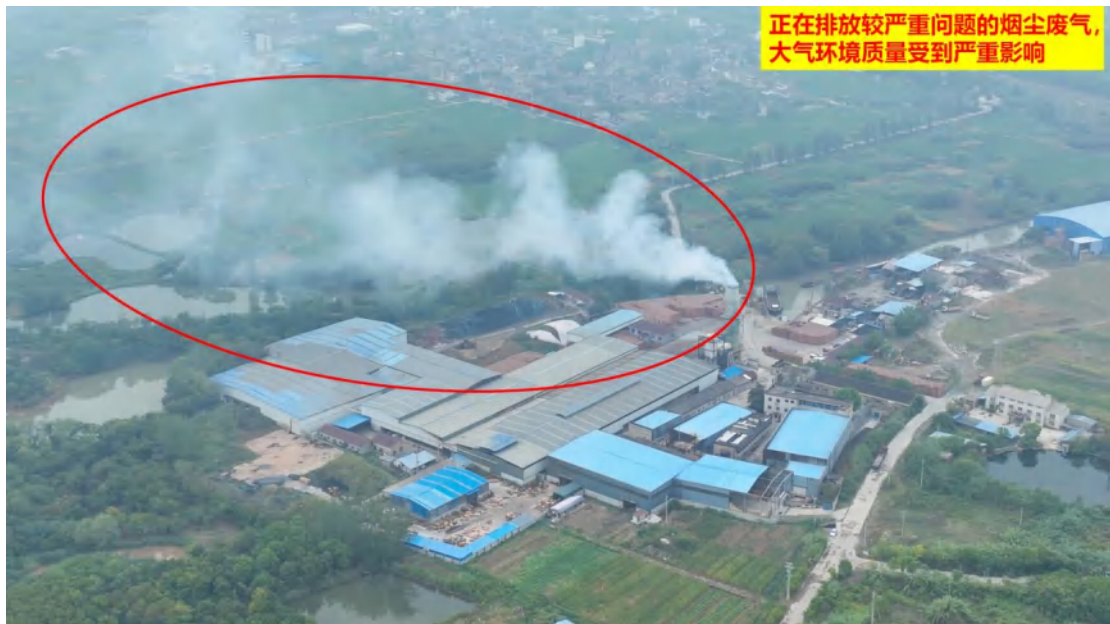
图 60、正在排放较严重问题的烟尘废气，大气环境质量受到严重影响
