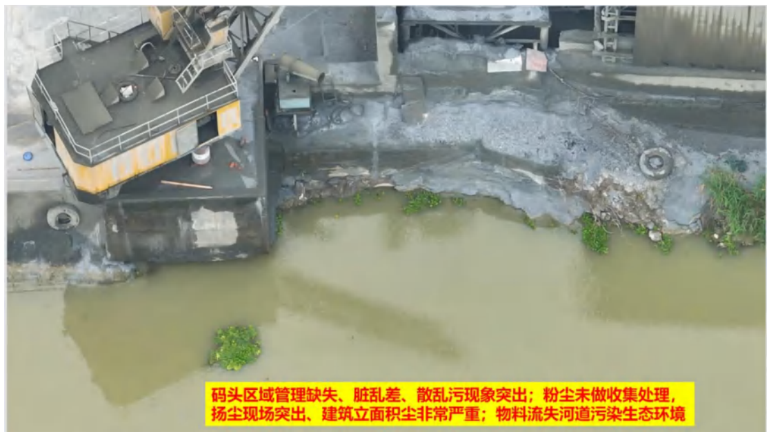
图 34、码头区域管理缺失、脏乱差、散乱污现象突出；粉尘未做收集处理，扬尘现场突出、建筑立面积尘非常严重；物料流失河道污染生态环境
