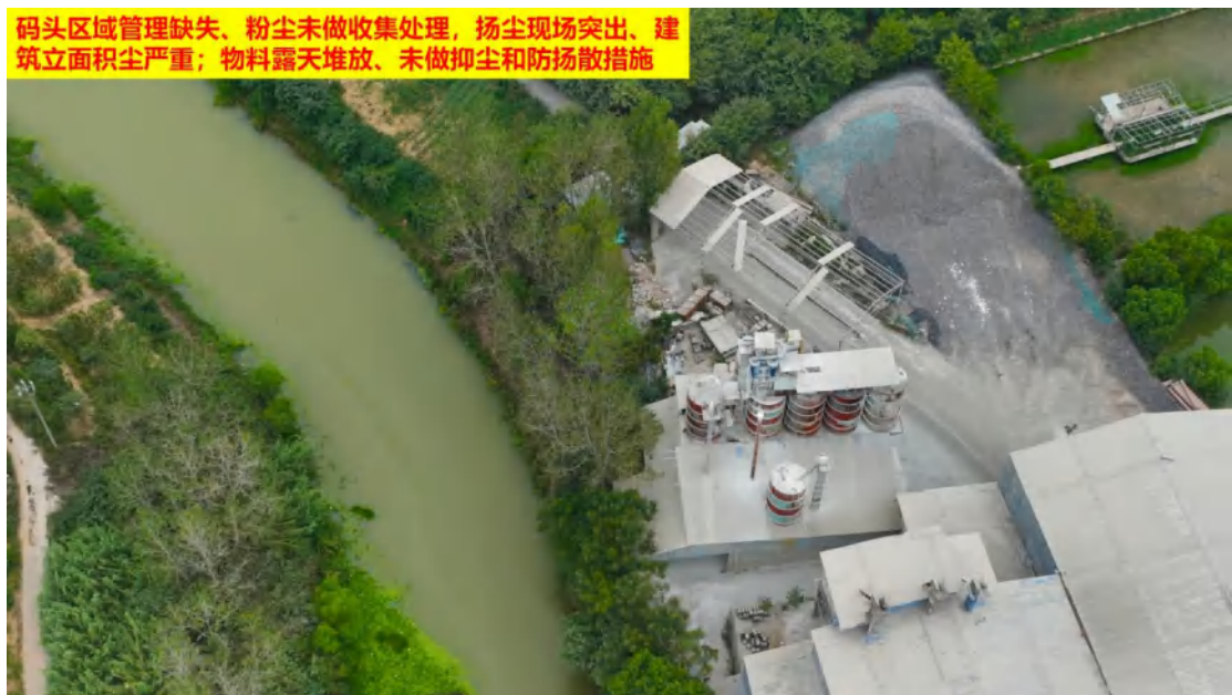
图 36、码头区域管理缺失、粉尘未做收集处理，扬尘现场突出、建筑立面积尘严重；物料露天堆放、未做抑尘和防扬尘措施
