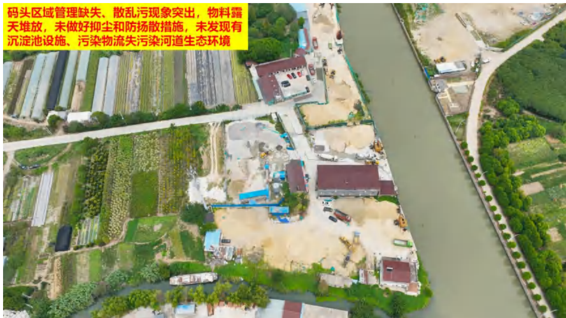
图 4、码头区域管理缺失、散乱污现象突出，物料露天堆放，未做好抑尘和防扬散措施，未发现有沉淀池设施、污染物流失污染河道生态环境
