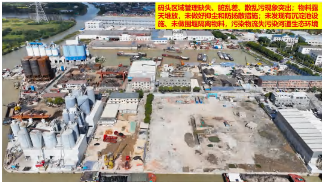
图 19、码头区域管理缺失、脏乱差、散乱污现象突出；物料露天堆放，未做好抑尘和防扬尘措施；未发现有沉淀池设施、未做围堰隔离物料，污染物流失污染河道生态环境
