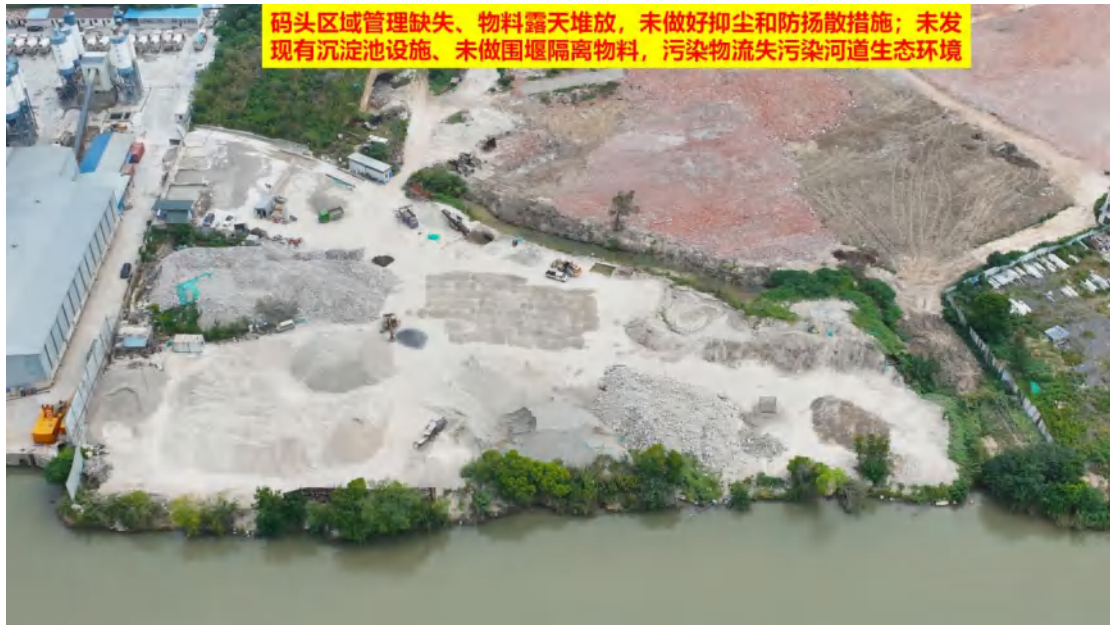
图 3、码头区域管理缺失、物料露天堆放，未做好抑尘和防扬散措施；未发现有沉淀池设施、未做围堰隔离物料，污染物流失污染河道生态环境
