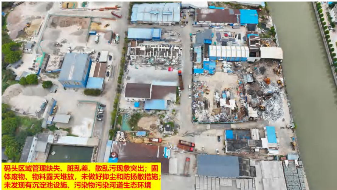
图 7、码头区域管理缺失、脏乱差、散乱污现象突出；固体废物、物料露天堆放，未做好抑尘和防扬散措施；未发现有沉淀池设施、污染物污染河道生态环境
