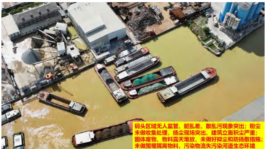
图 26、码头区域无人监管、脏乱差、散乱污现象突出；粉尘未做收集处理，扬尘现场突出、建筑立面积尘严重；固体废物、物料露天堆放，未做好抑尘和防扬
