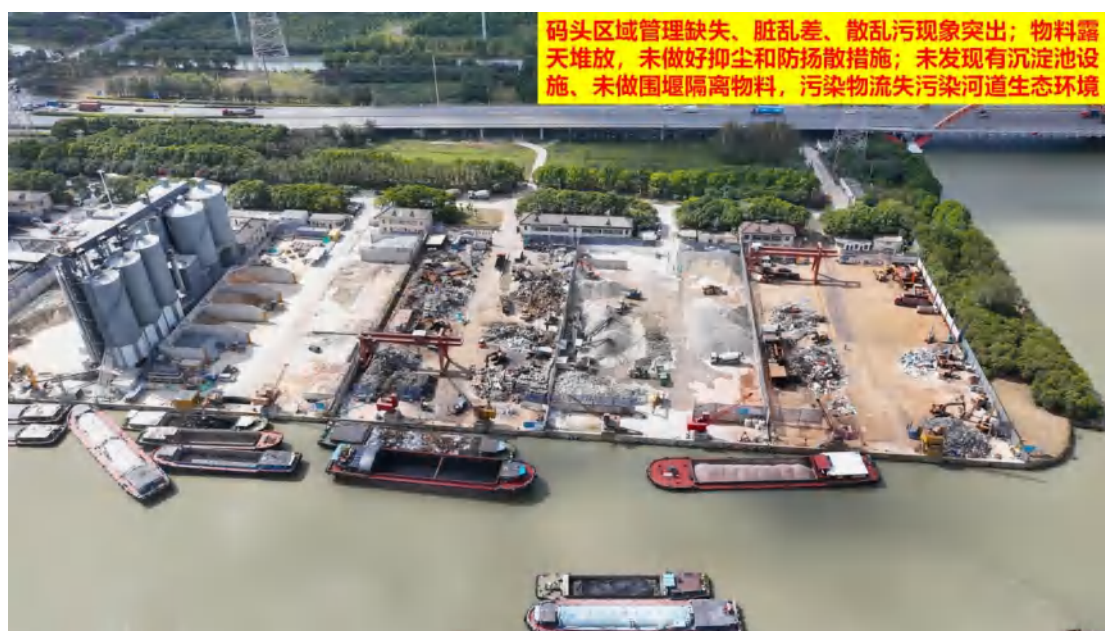
图 29、码头区域管理缺失、脏乱差、散乱污现象突出；物料露天堆放，未做好抑尘和防扬散措施；未发现有沉淀池设施、未做围堰隔离物料，污染物流失污染河道生态环境
