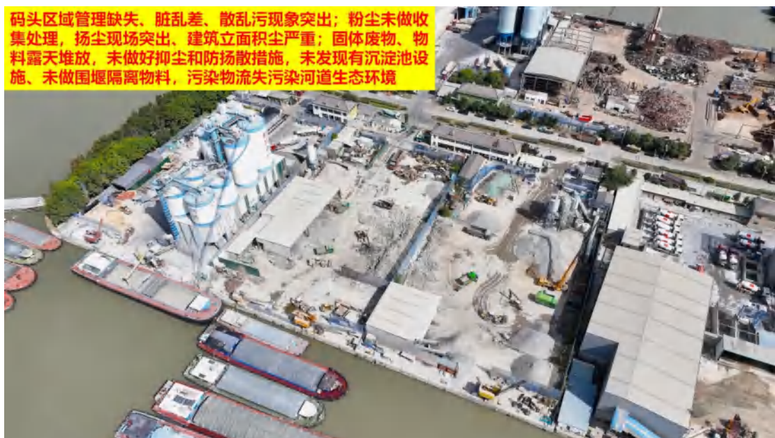
图 31、码头区域管理缺失、脏乱差、散乱污现象突出；粉尘未做收集处理，扬尘现场突出、建筑立面积尘严重；固体废物、物料露天堆放，未做好抑尘和防扬尘措施，未发现有沉淀池设施、未做围堰隔离物料，污染物流失污染河道生态环境
