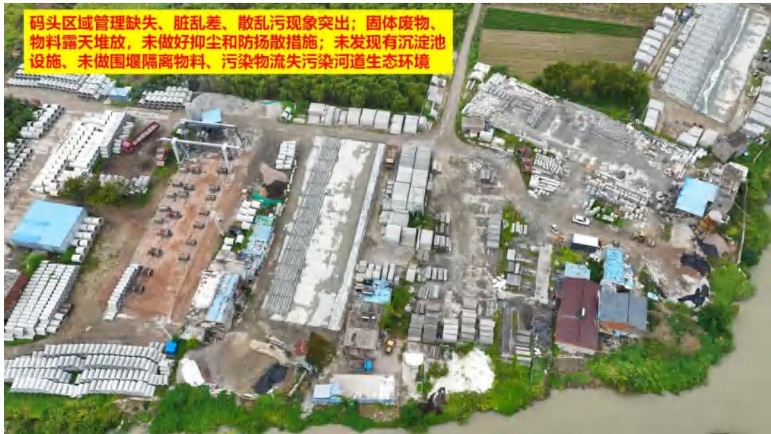
图 21、码头区域管理缺失、脏乱差、散乱污现象突出；固体废物、物料露天堆放，未做好抑尘和防扬尘措施；未发现有沉淀池设施、未做围堰隔离物料、污染物流失污染河道生态环境
