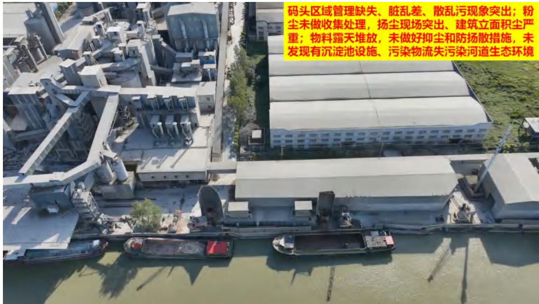
图 48、码头区域管理缺失、脏乱差、散乱污现象突出；粉尘未做收集处理，扬尘现场突出、建筑立面积尘严重；物料露天堆放，未做好抑尘和防扬尘措施，未发现有沉淀池设施、污染物流失污染河道生态环境
