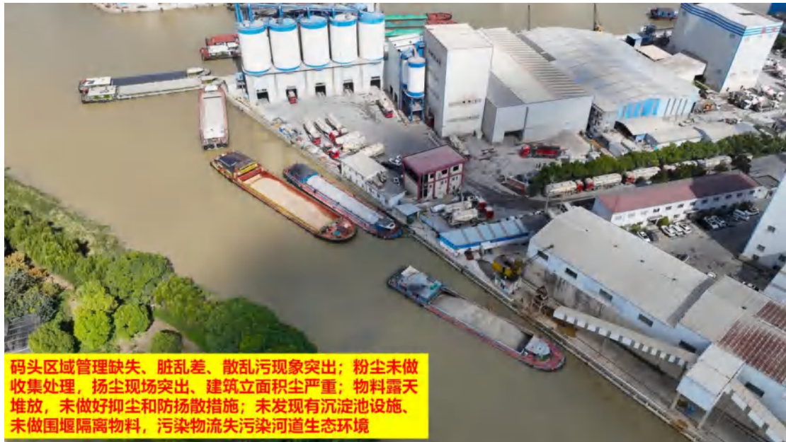
图 18、码头区域管理缺失、脏乱差、散乱污现象突出；粉尘未做收集处理，扬尘现场突出、建筑立面积尘严重；物料露天堆放，未做好抑尘和防扬尘措施；未发现有沉淀池设施、未做围堰隔离物料，污染物流失污染河道生态环境
