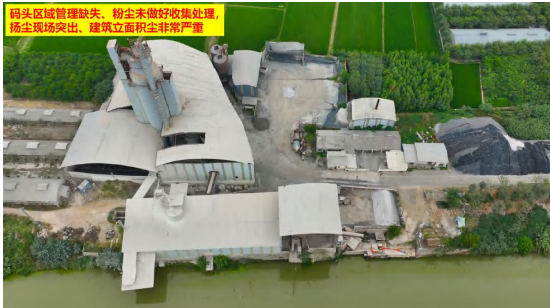
图 44、码头区域管理缺失、粉尘未做好收集处理，扬尘现场突出、建筑立面面积尘非常严重
