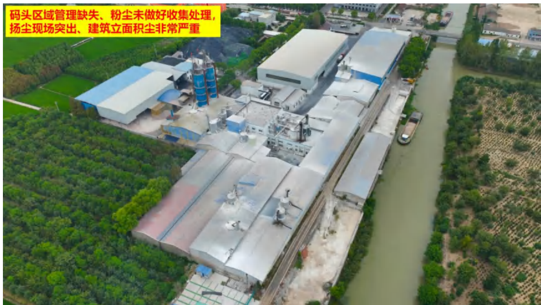
图 45、码头区域管理缺失、粉尘未做好收集处理，扬尘现场突出、建筑立面面积尘非常严重
