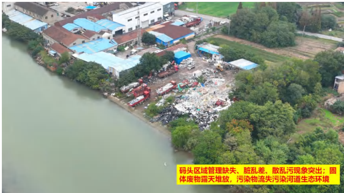
图 22、码头区域管理缺失、脏乱差、散乱污现象突出；固体废物露天堆放，污染物流失污染河道生态环境
