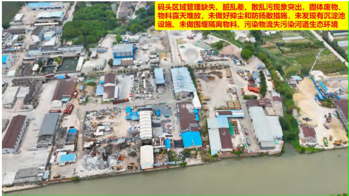
图 1、码头区域管理缺失、脏乱差、散乱污现象突出，固体废物、物料露天堆放，未做好抑尘和防扬尘措施，未发现有沉淀池设施、未做围堰隔离物料、污染物流失污染河道生态环境
