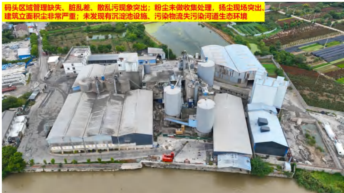
图 47、码头区域管理缺失、脏乱差、散乱污现象突出；粉尘未做收集处理，扬尘现场突出、建筑立面积尘非常严重；未发现有沉淀池设施、污染物流失污染河道生态环境
