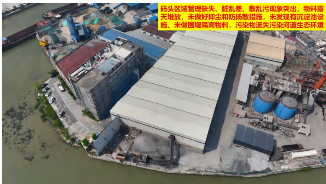
图 28、码头区域管理缺失、脏乱差、散乱污现象突出，物料露天堆放，未做好抑尘和防扬散措施，未发现沉淀池设施、未做围堰隔离物料，污染物流失污染
