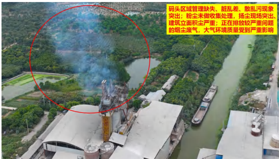
图 57、码头区域管理缺失、脏乱差、散乱污现象突出；粉尘未做收集处理，扬尘现场突出、建筑立面积尘严重；正在排放较严重问题的烟尘废气，大气环境质量受到严重影响
