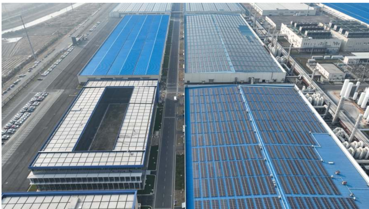
图 4-10 东方日升(常州)新能源有限公司屋顶光伏
