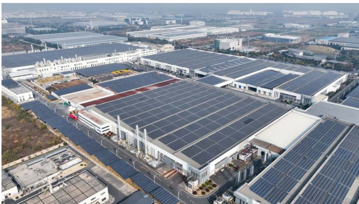
图 4-9 常州亿晶光电科技有限公司屋顶光伏
