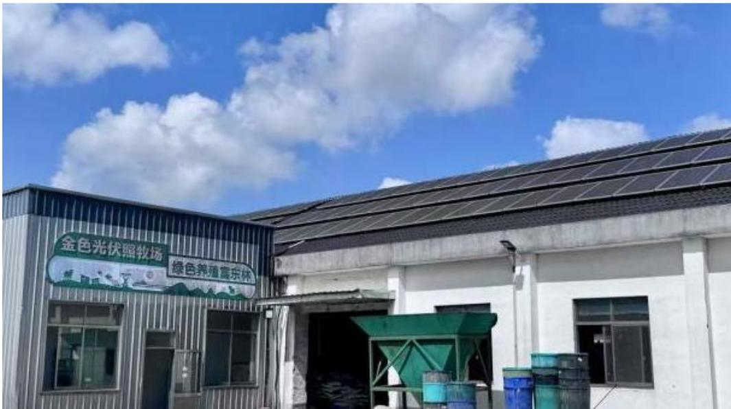
图 18 东林村 200 千瓦屋顶分布式光伏生态羊场外景（绿色江南摄）
