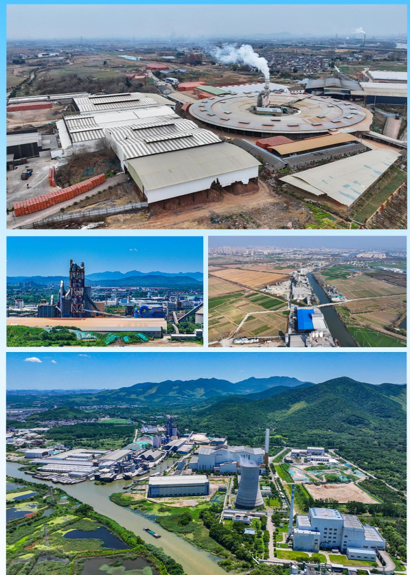
建材行业照片
