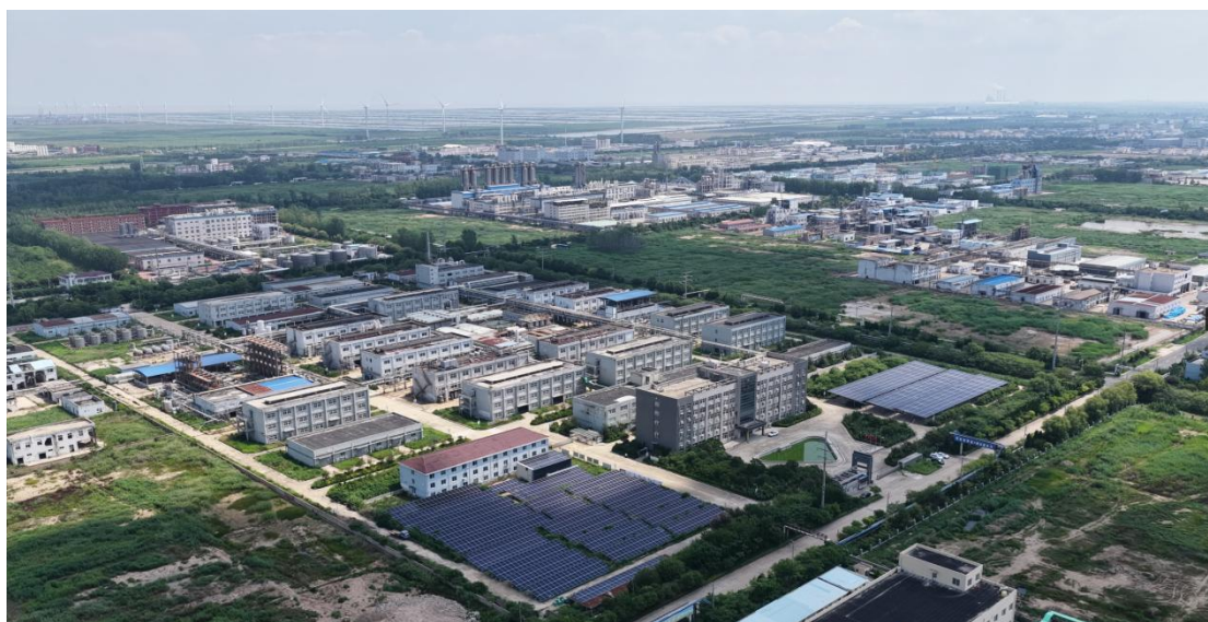
图 27：江苏滨海沿海工业园利用闲置场地铺设光伏
