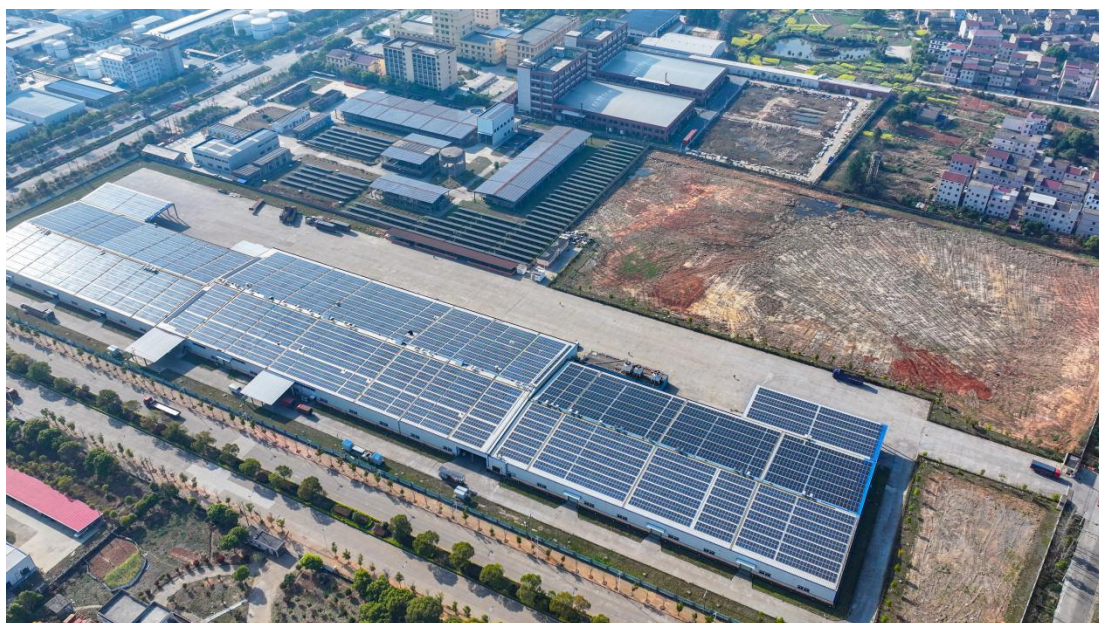
图 28：江西丰城工业园利用企业屋顶、空地铺设光伏
